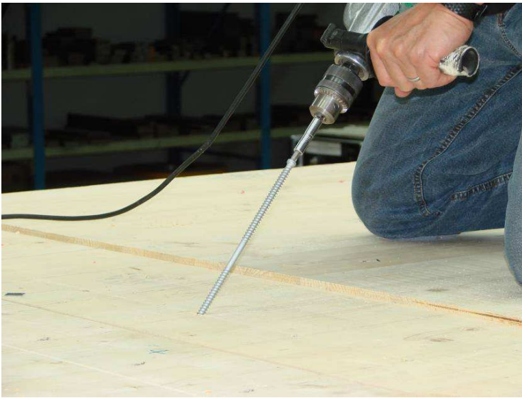
Bild 3.18: Eindrehen der Vollgewindeschrauben SFS-WT T40 8.2 x 245 mm unter 45° zur Aufnahme der Schubkräfte
