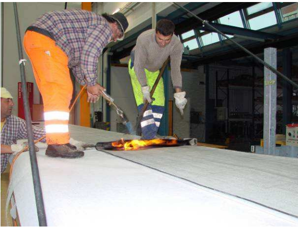
Bild 3.27: Verschweissen der PBD-Abdichtung
