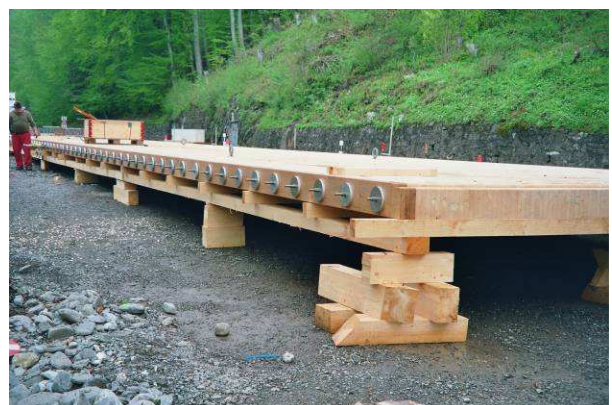
Bild 3.11: Einsatz von QS-Platten im (Strassen-) Brückenbau: Selgisbrücke Muotathal, SZ
