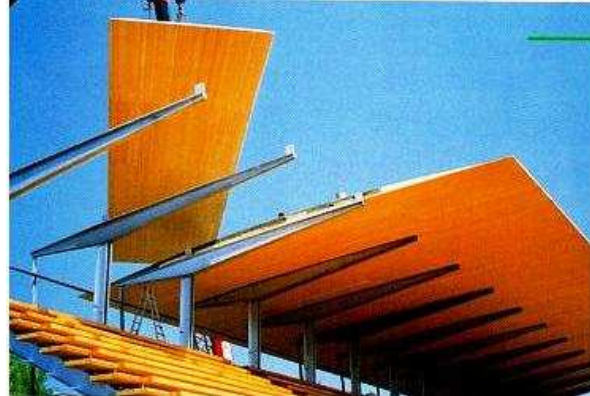
Bild 3.2: Einsatz von Massivholzplatten im Hochbau als Wandelement (links) und als Dachelement (rechts)
