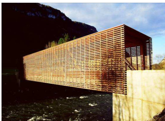
Bild 3.11: Einsatz von QS-Platten im (Strassen-) Brückenbau: Selgisbrücke Muotathal, SZ
