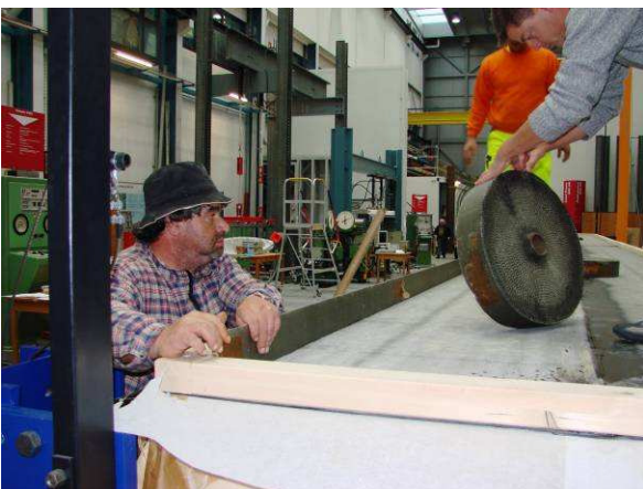
Bild 3.29: Karton als Trennschicht zwischen Belag und Randelement
