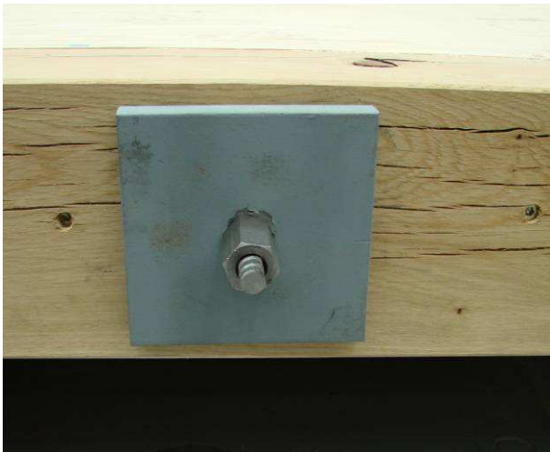
Bild 3.15: Ankerplatte 160 x 160 x 20 mm aus Stahl S235, zinkstaubgrundiert
