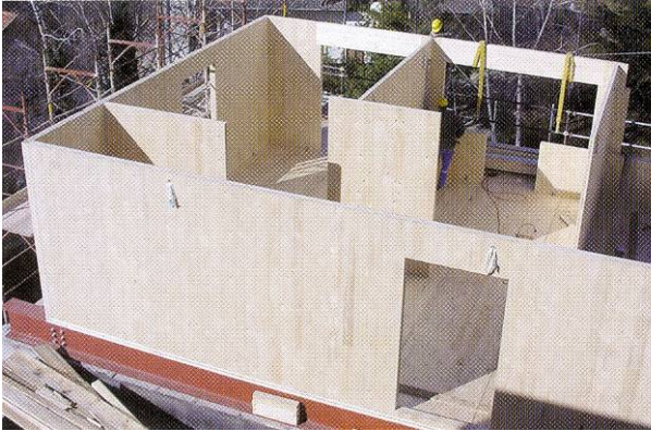
Bild 3.2: Einsatz von Massivholzplatten im Hochbau als Wandelement (links) und als Dachelement (rechts)
