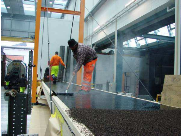
Bild 3.31: Einbau der 2. GA-Schicht ( t= 30\text{ mm} )
