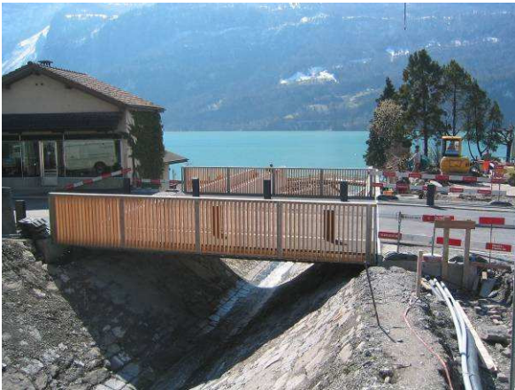
Bild 3.3: Massivholzplatten im Brückenbau: Trachtbachbrücke Brienz, BE (links) und Wiggerbrücke bei Egozwil, LU (rechts)
