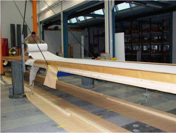
Bild 3.25: Auflegen eines 2-lagigen Glasvlieses als Trennschicht
