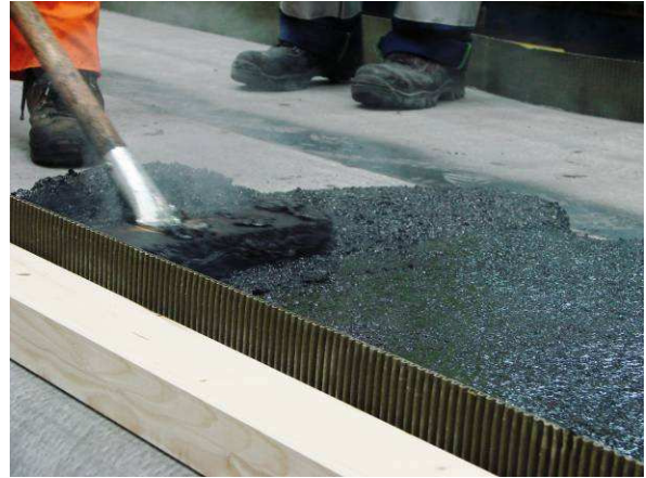
Bild 3.32: Detail Belagseinbau
