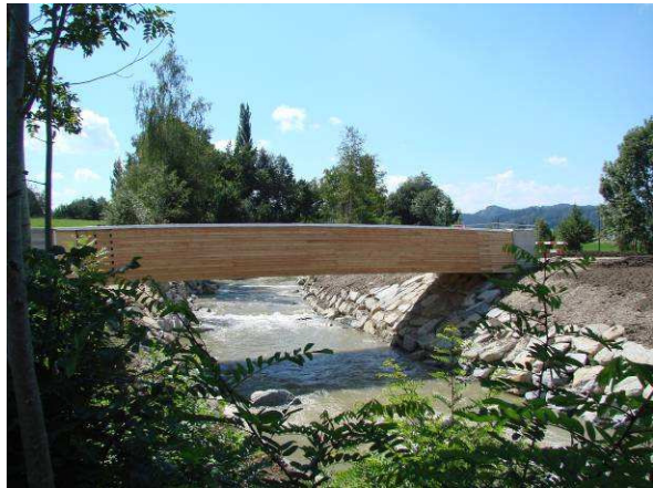
Bild 3.3: Massivholzplatten im Brückenbau: Trachtbachbrücke Brienz, BE (links) und Wiggerbrücke bei Egozwil, LU (rechts)
