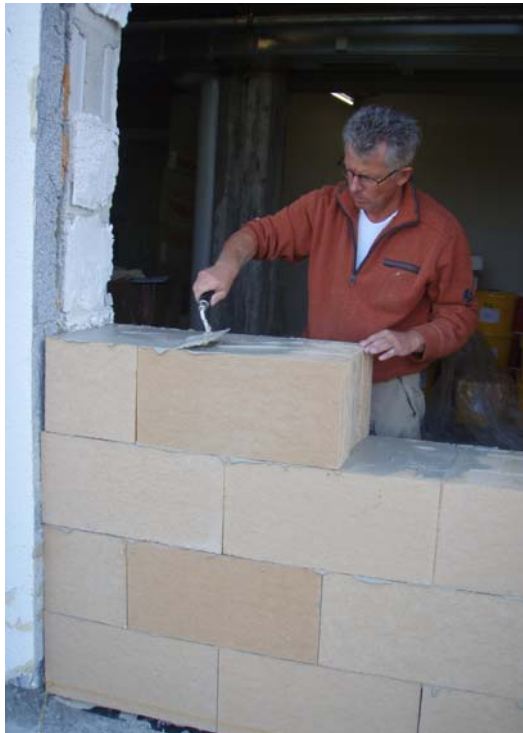
Abbildung 5: Aufmauern der Prüfwand
