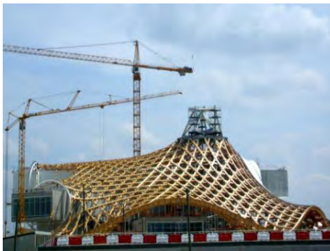
Figure 17 : Centre Pompidou à Metz en Juin 2009
