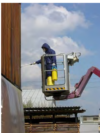
Abbildung 2: Vorbehandlung mit Chemikalien (links) und Versuchsfelder (rechts) an der Fassade 3.
