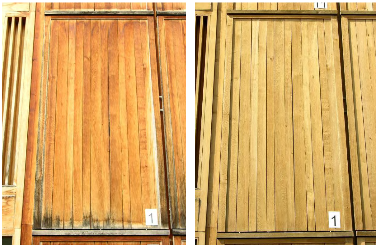
Abbildung 19: Beispiel für die Homogenisierung der Farbe mit einer Reinigung von 110 bar und 80°C Wasser auf einer Eichenfassade (Fassade 3) nicht vorbehandelt (Feld 1) Zustand vor (links) und nach (rechts) der Reinigung.
