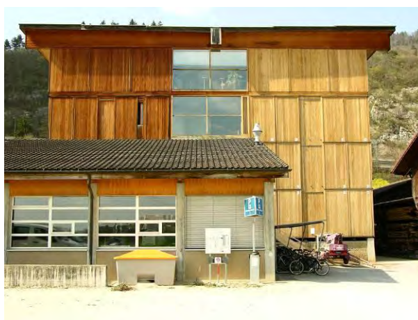
Abbildung 2: Vorbehandlung mit Chemikalien (links) und Versuchsfelder (rechts) an der Fassade 3.
