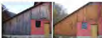
Homogénéisation par nettoyage d'une façade en Epicéa à Péry (JU) (Photo : HESB ABGC)
