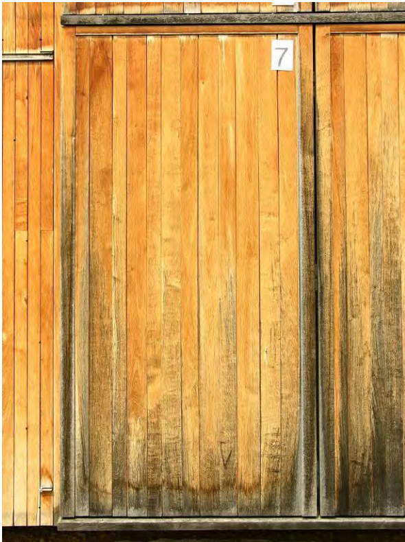
Abbildung 20: Beispiel Homogenisierung der Farbe mit einer Reinigung von 110 bar und 80°C Wasser auf einer Eichenfassade (Fassade 3) vorgesprüht mit Wasserstoffperoxid 20% (Feld 7 Unten). Zustand vor (links) und nach (rechts) der Reinigung.
