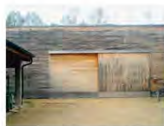
Stark ungleichmässige Verwitterung einer Robinienfassade (ostexponiert) infolge konstruktiver Gegebenheiten.
