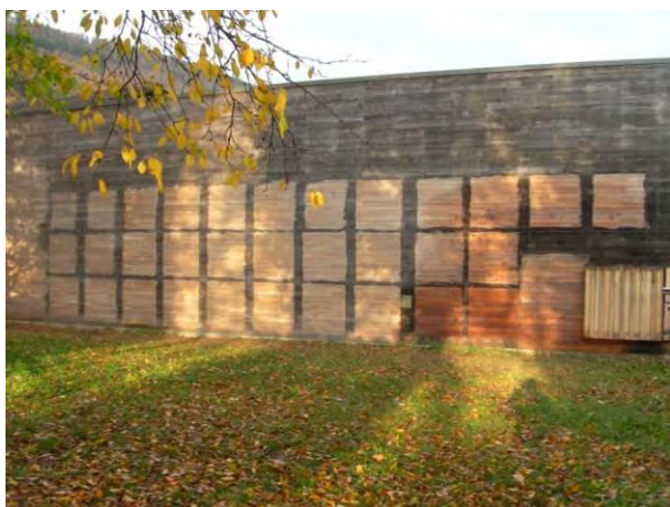
Abbildung 1: Versuchsfelder und Reinigung an der Fassade 1 (rechts) und der Fassade 4 (links).
