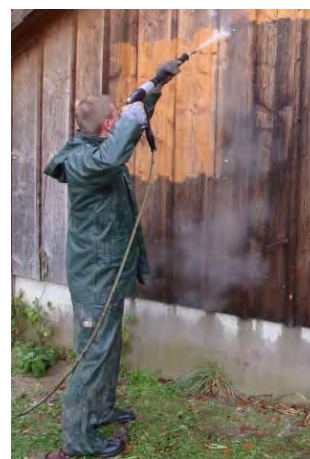
Abbildung 1: Versuchsfelder und Reinigung an der Fassade 1 (rechts) und der Fassade 4 (links).
