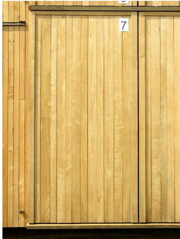
Abbildung 20: Beispiel Homogenisierung der Farbe mit einer Reinigung von 110 bar und 80°C Wasser auf einer Eichenfassade (Fassade 3) vorgesprüht mit Wasserstoffperoxid 20% (Feld 7 Unten). Zustand vor (links) und nach (rechts) der Reinigung.
