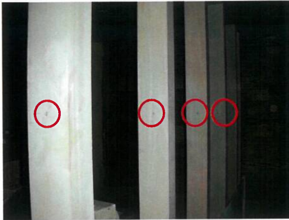
Abbildung 43: Querverschraubung der Stützen mit SFS Doppelgewindeschraube WT-T 4,5x60 mm
