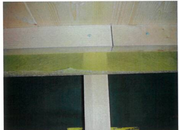
Abbildung 47: Auslegen der Massivholz-Deckenelemente auf dem Holzrahmen
