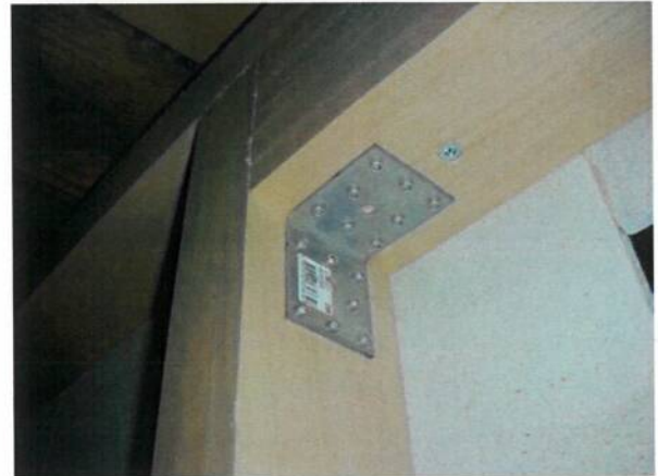
Abbildung 44: Fügen der Holzrahmen; Winkeleisen mit SFS Doppelgewindeschrauben WT-T 4,5x60
