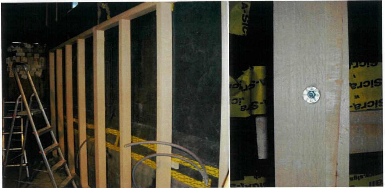
Abbildung 42: Holzrahmen bei Trenn- und Aussenwänden
