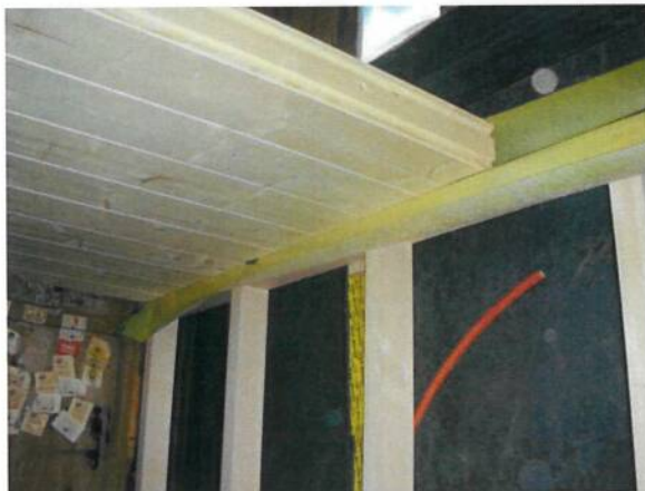
Abbildung 47: Auslegen der Massivholz-Deckenelemente auf dem Holzrahmen
