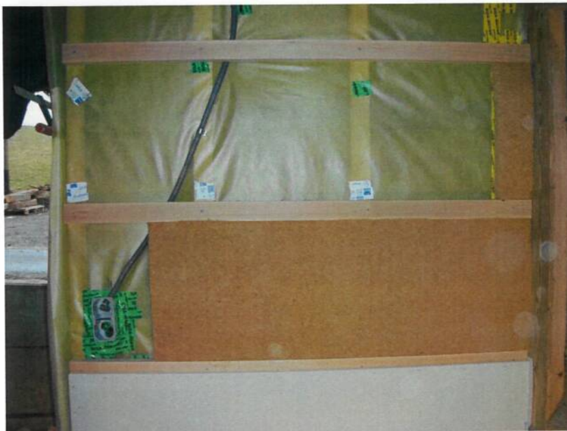
Abbildung 49: Wandaufbau mit Dampfsperre, Lattenrost, innere Dämmschicht, Beplankung
