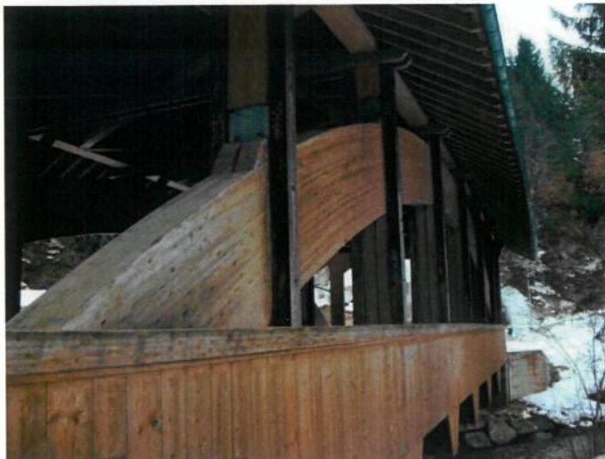
Abbildung 8: Dörlbrücke in Eggiwil BE mit Hängern und Querträgern aus Buchen-BSH
