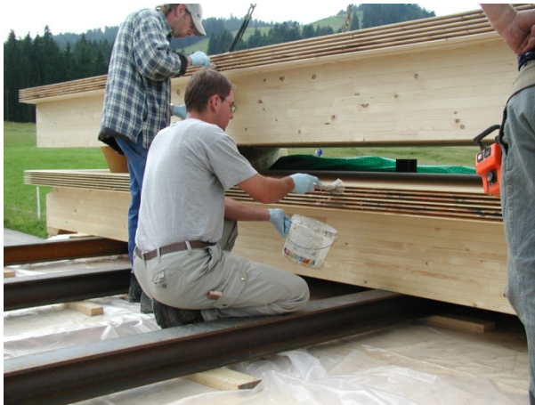
Abb. 6: Keilzinkenverbindung Geisseggbrücke Eriz BE
