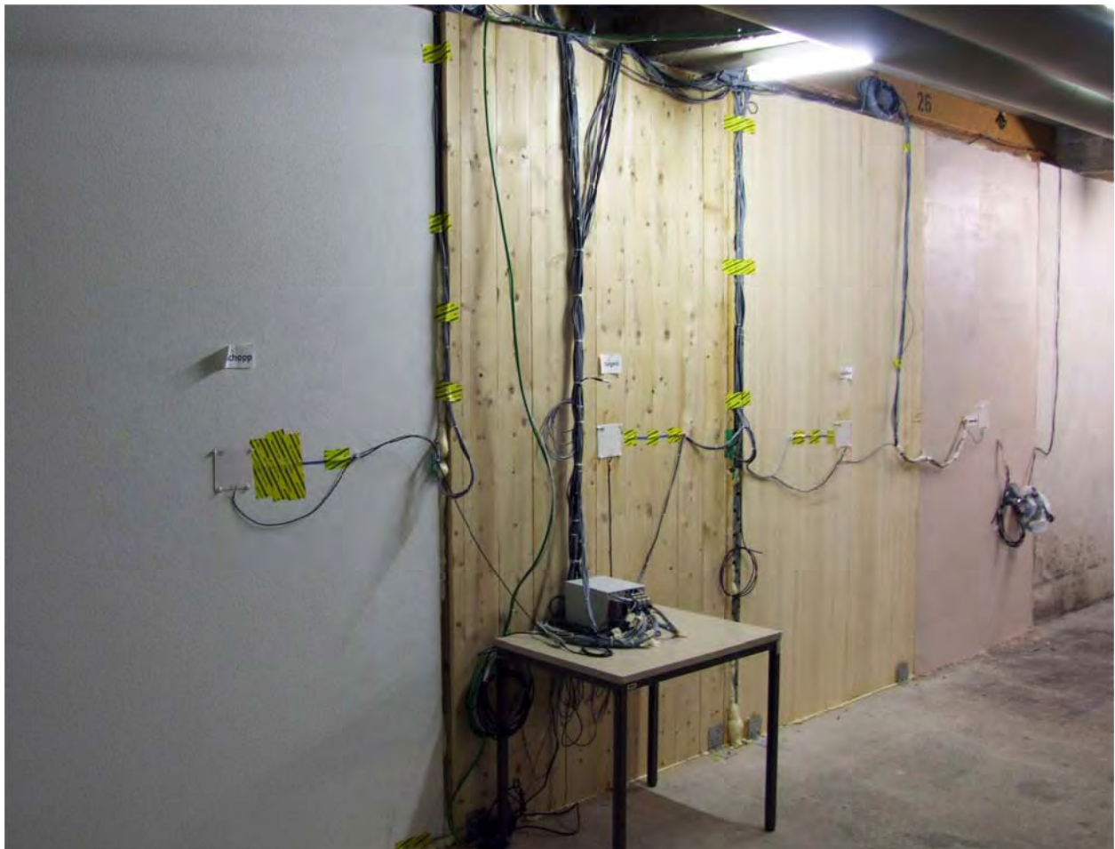
Abb. 2: Blick im Innern des Testgebäudes auf die Vernetzung der gesamten Messtechnik nach der Installation.
