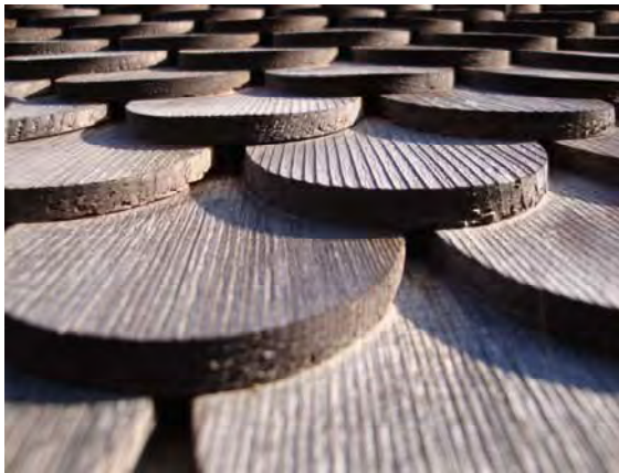
Abb. 23 abgewitterte Oberfläche einer Fichtenschindel mit deutlicher Ausbildung der Riffelstruktur, süd-exponiert nach 26 Monaten Bewitterung
