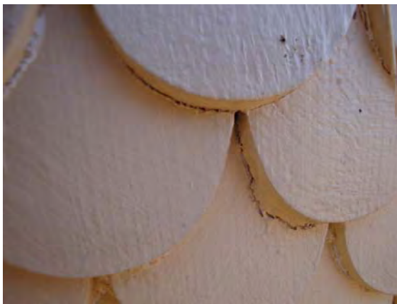
Abb. 16 abgerissener Farbfilm infolge „verklebter“ Schindeln, Buche West-exponiert
