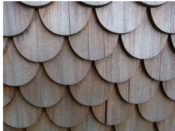
Abb. 24 Schindelschirm Lärche mit relativ viel gerissenen und gespaltenen Schindeln, westexponiert nach 14 Monaten Bewitterung
