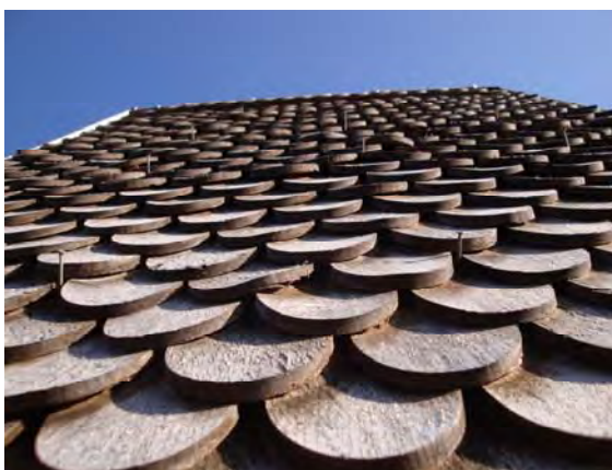
Abb. 18 Buchschindeln mit deutlicher Verformung in der Fläche führen zu einem unruhigen Erscheinungsbild, Buche Süd-exponiert nach 26 Monaten Bewitterung
