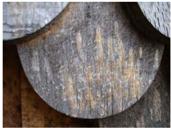
Abb. 17 Wespenfrass auf einer unbehandelten Bucheschindel, Exposition West nach 26 Monaten Bewitterung
