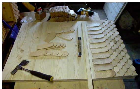
Abb. 7 Herstellung der Musterflächen, Befestigung der Schindeln entsprechend Fachweite und Fugenbreite
