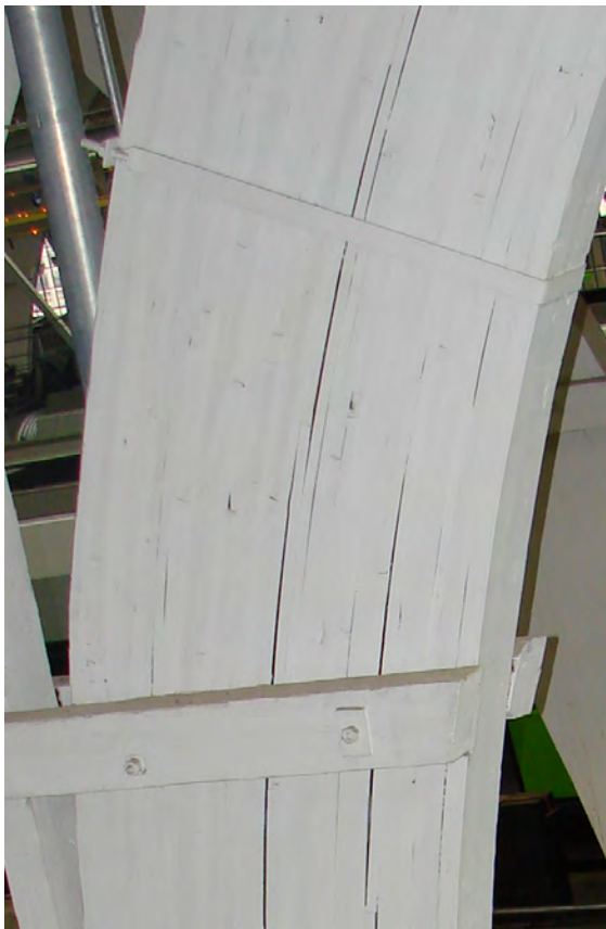
Bild 2: Träger des Lokdepots Aebimatt mit deutlichen Delaminationen der Klebfugen
