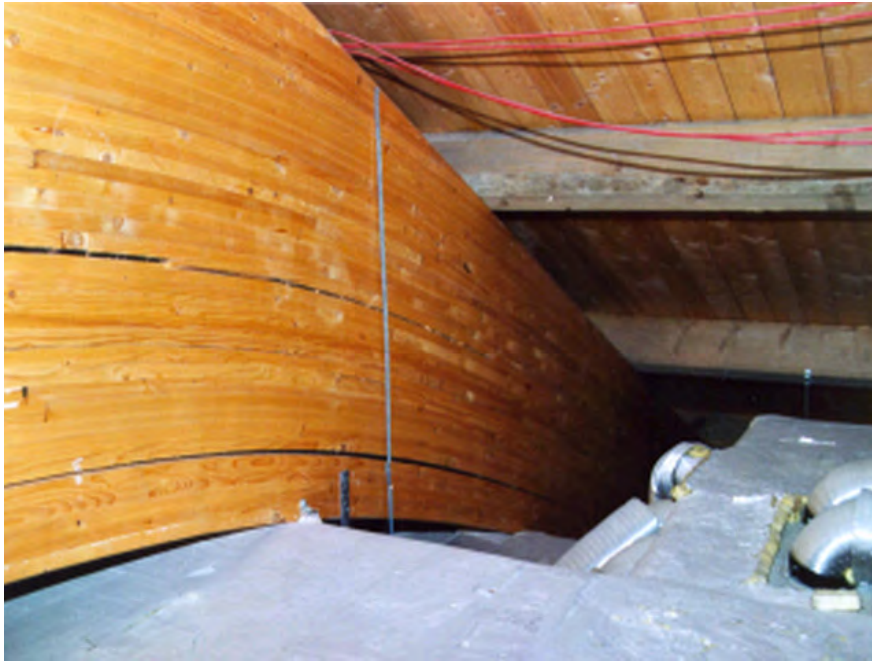
Bild 1: Offene Fugen an einem gekrümmten BSH Träger
