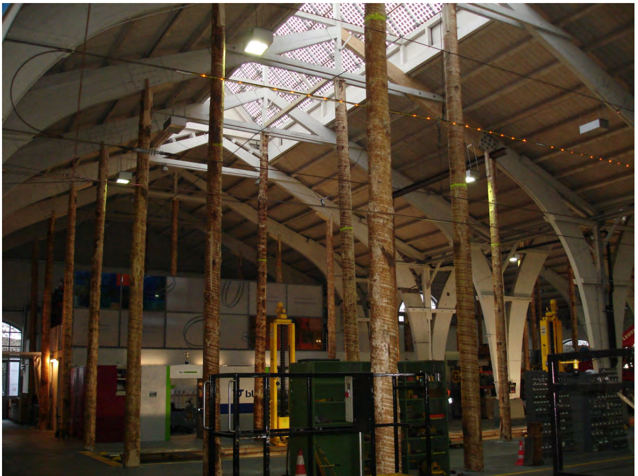
Bild 37: Absicherung des Tragwerks im BLS Lokdepot Aebimatt mit Rundholzstützen (Photo timbatec).
