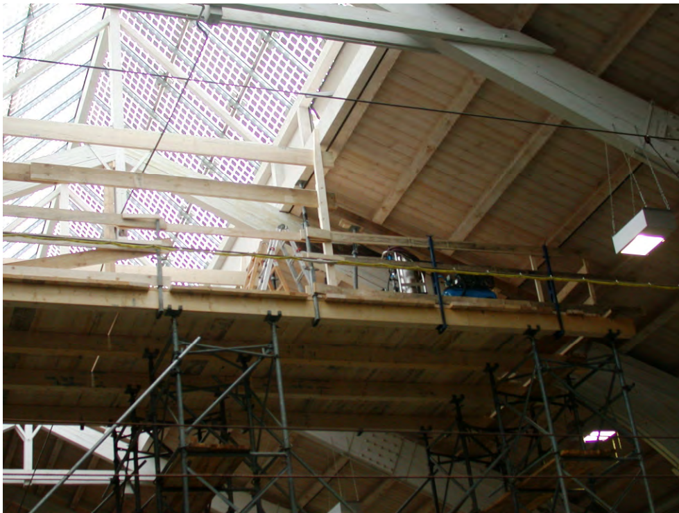
Bild 4: Hallendach im Firstbereich mit Podest zur Sanierung und Auswechslung des Trägers
