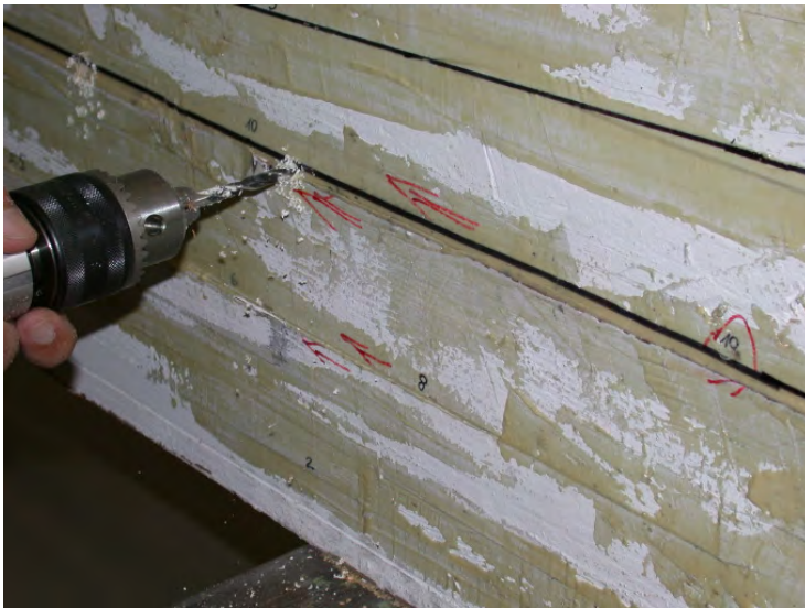
Bild 7: Bohren der Löcher zum Verfüllen der Fugenöffnungen
