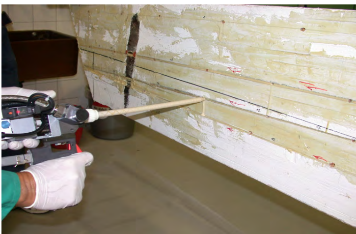
Bild 11: Ausspritzen einer Delamination durch ein gebohrtes Loch
