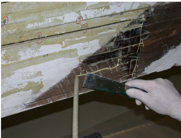
Bild 6: Verspachteln der Fugen
