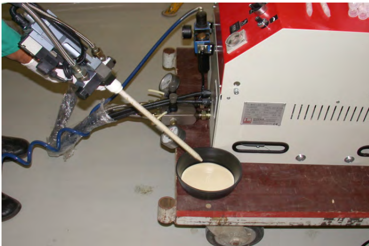
Bild 10: Injektionswerkzeug zum Verfüllen der Delaminationen
