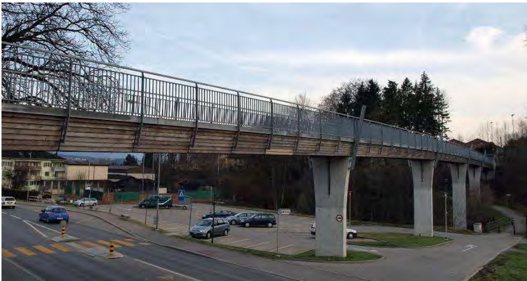
Abbildung 3.9: Ansicht der Passerelle über die Kantonsstrasse in Sins. Im Vordergrund sind die Felder mit Spannweiten von 22.24 m.
