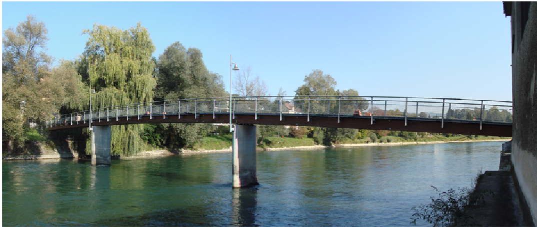
Abbildung 3.15: Ansicht des Stadtlüstegs in Mellingen.
