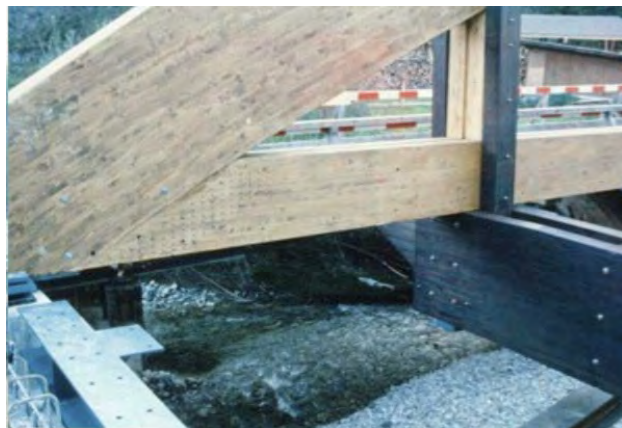
Abbildung 6.6: Hängepfosten und Querträger aus teerölimprägnierter Buche [3].
