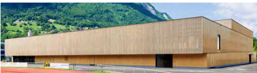
Abbildung 6.12: Ansicht Sporthalle Sargans mit auskragender Holz-Beton-Verbunddecke [12]
