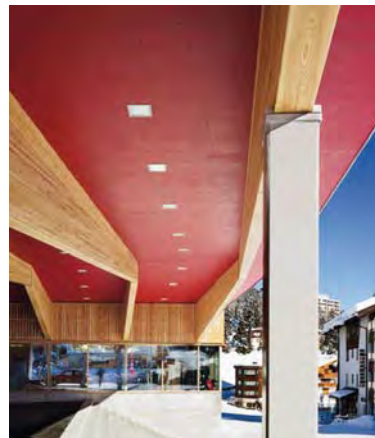
Abbildung 6.11: Untersicht der Kragträger aus Esche [11]
