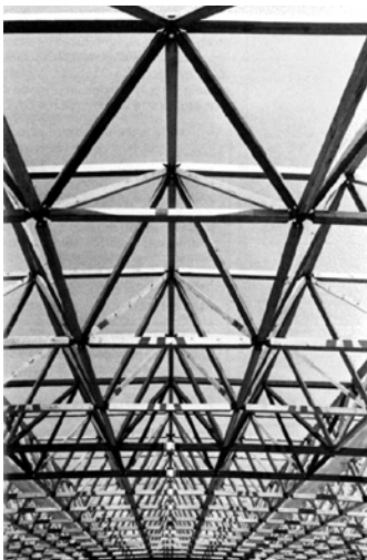
Abbildung 6.2: Raumfachwerk mit Stäben aus Buchen-BSH [2]
