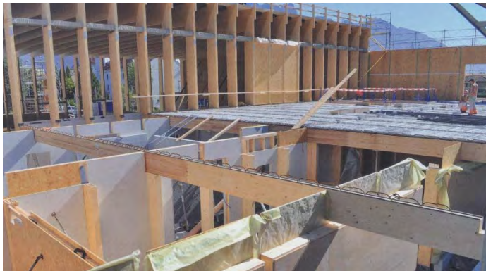
Abbildung 6.14: Eschen-Fichten-BSH-Träger der Holz-Beton-Verbunddecke [12]
