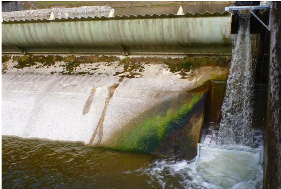
Figure 4 : Echanture de dévalaison et bassin de réception à la prise d'eau de la centrale de Waldhalde sur la Sihl. Source : Boller L., 2017.
