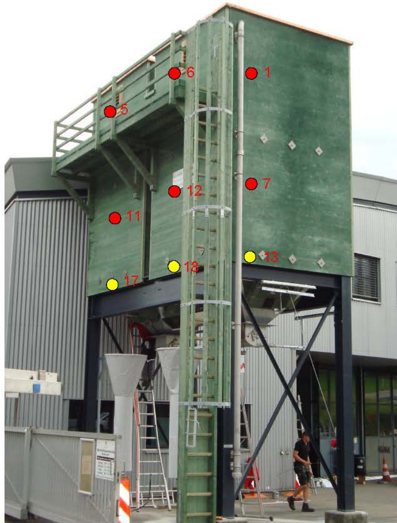
Silokonstruktion Wollerau (2x40m³)
