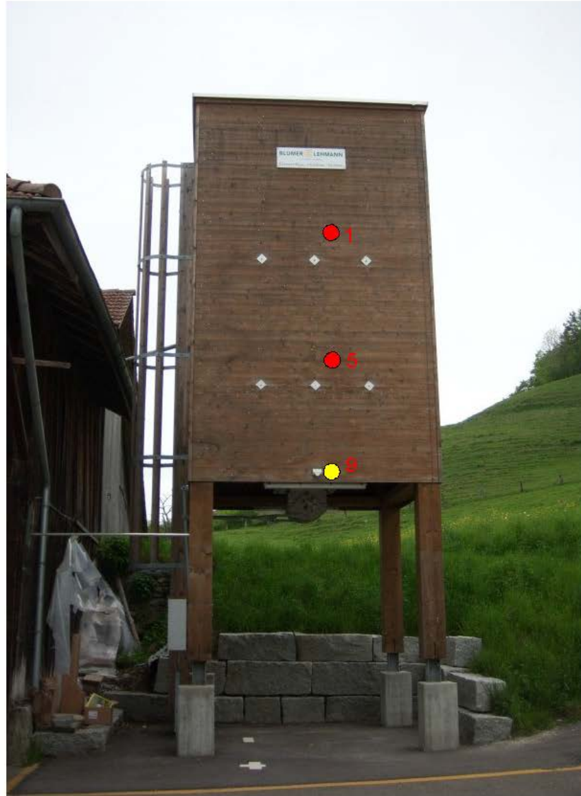
Silokonstruktion Aeugst am Albis (1x40m³)
