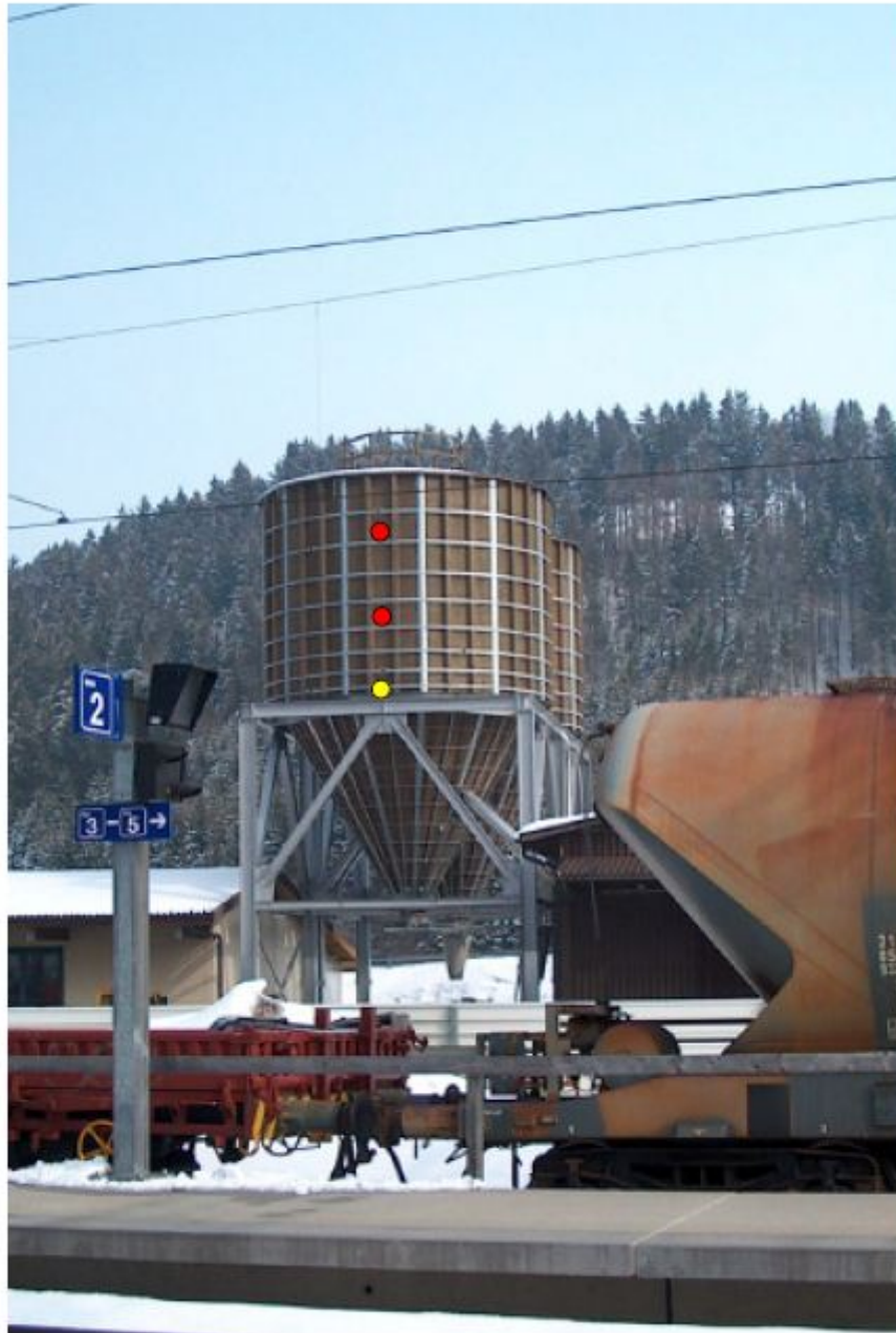
Silokonstruktion Biberbrugg (2x300m 3 )
