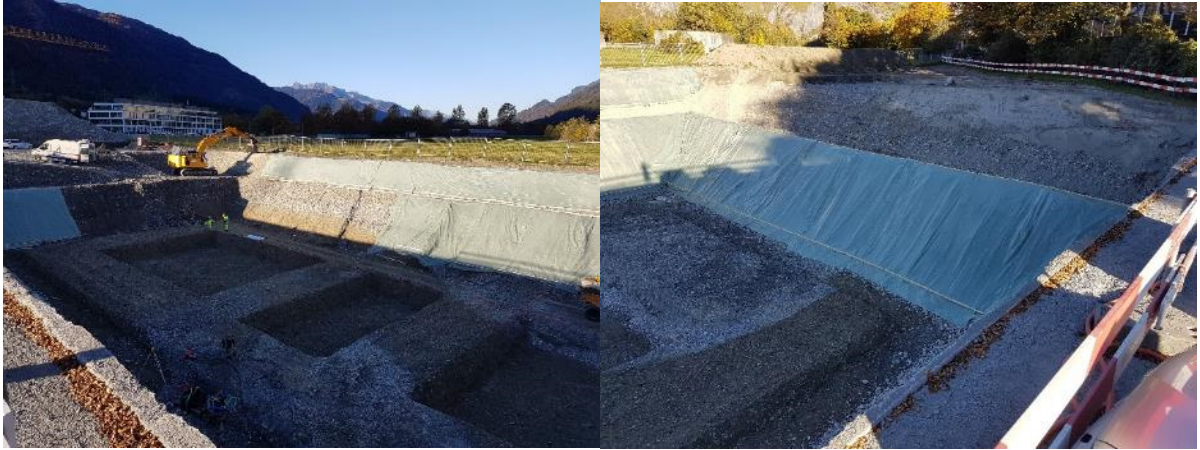
Abb. 1 Aushub Neubau Oblamatik AG
