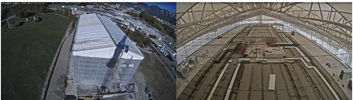
Abb. 5 Stand der Baustelle Ende Oktober 2018
