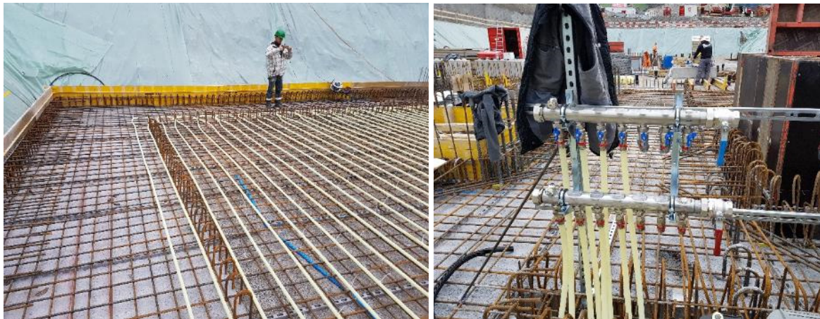
Abbildung 2: Verlegung der Leitungen für die Bodenplattenaktivierung.
