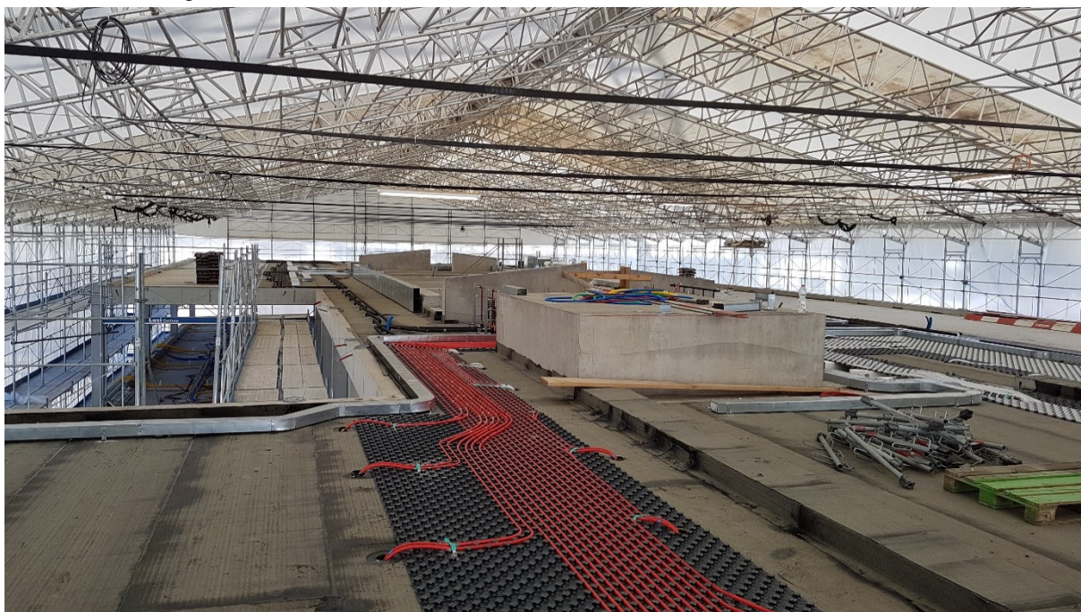
Abb. 7 Das Gebäude wurde im Winter mit einem Dach abgedeckt
