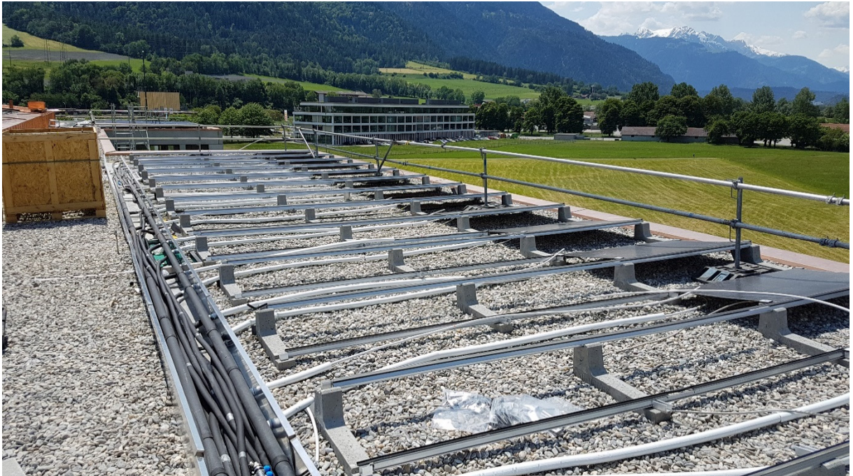
Abb. 8 Aufständering für das PVT-Feld
