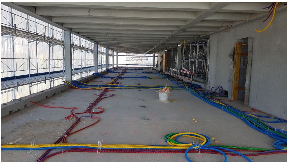
Abb. 6 Vorbereitung der Installationsschläuche
