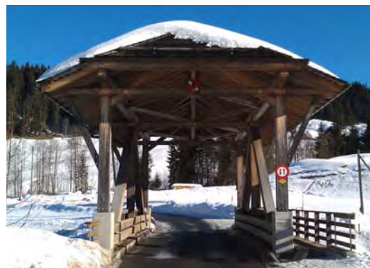
Geisseggbrücke, Eriz (BE)
