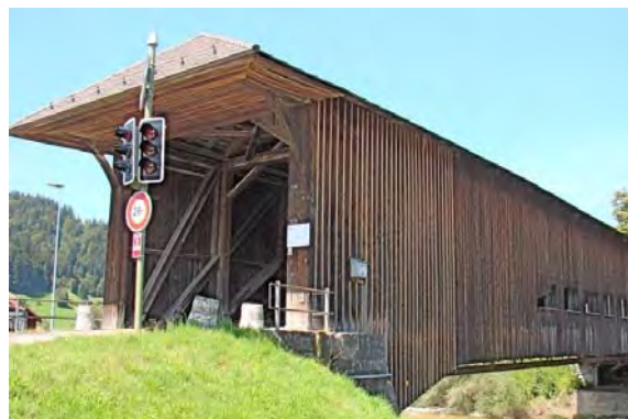
Schüpbachbrücke, Schüpbach (BE)
