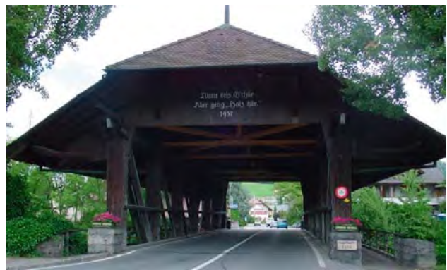
Zulgbrücke, Steffisburg (BE)
