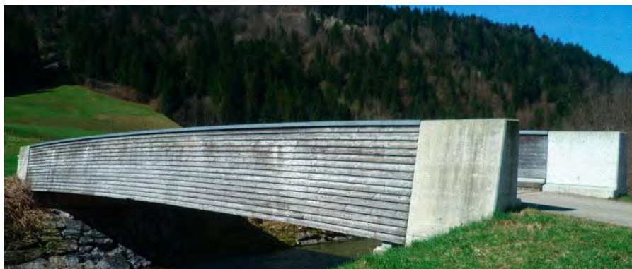
Schartenmattbrücke, Marbach (LU)
