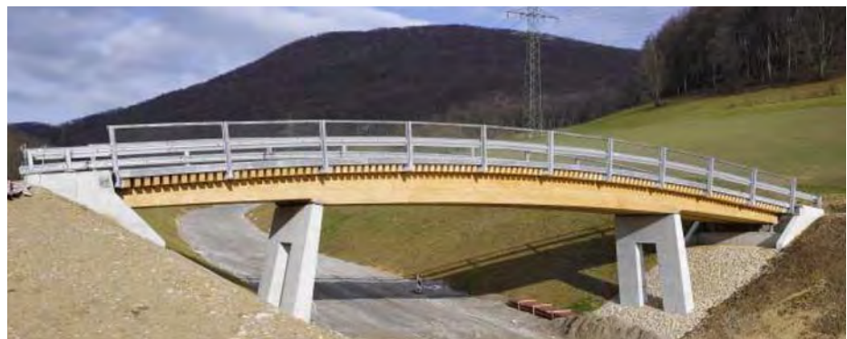
Horenbrücke, Küttingen (AG)
