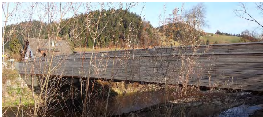
Obermattbrücke, Obermatt (BE)
