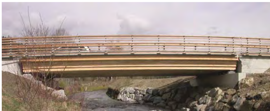
Waldmattbrücke (Luthernbrücke), Schötz Ohmstal (LU)
