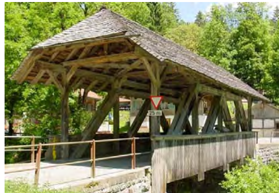
Tächelbrücke (Heidenweidli), Oberwil (BE)
