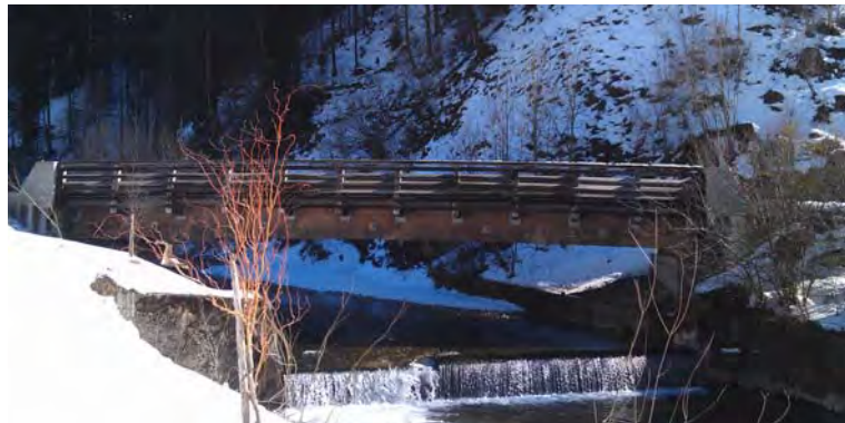
Schachenhausbrücke, Trub (BE)
