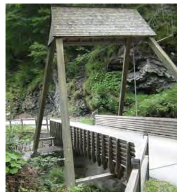
Hellstutzbrücke, Schiers (GR)
