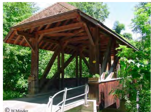
Wüstenbachbrücke, Oberwil (BE)
