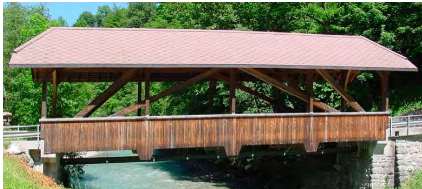
Klosterbrücke, Därstetten (BE)
