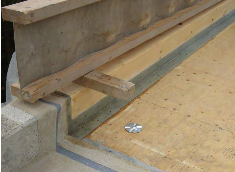
Abbildung 3: Dampfdruckentspannungsöffnung (Bildquelle: Aeschlimann AG)
