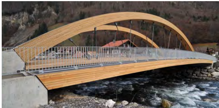
Kirchenbrücke, Muotathal (SZ)
