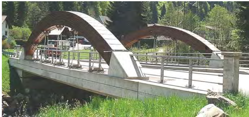
Zollhausbrücke, Sangernboden (FR)
