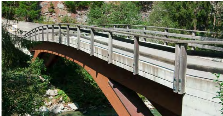
Crestawald-Brücke (Festungsmuseumsbrücke), Sufers (GR)
