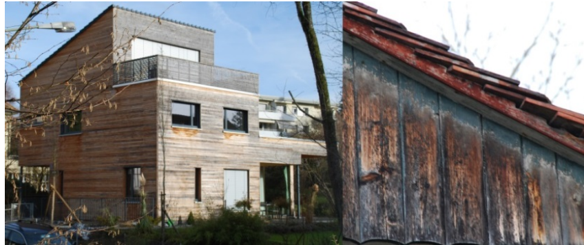
Abbildung 2.13: V.l.n.r. kubisches Gebäude mit Holzfassade, Schutz durch Dachüberstand
