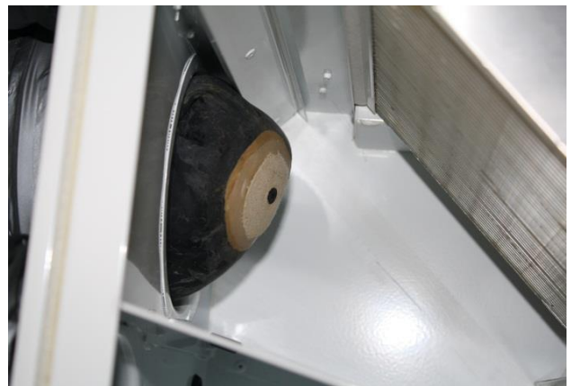
Abbildung 5.7: Mit Ballon abgedichteter Luftschacht der kontrollierten Lüftungsanlage.
