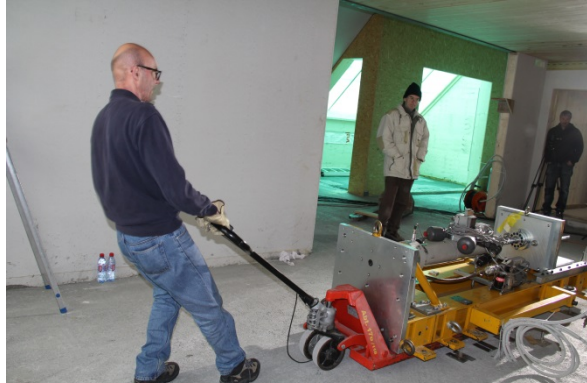
Abbildung 5.20: Längsverschiebung des Schwingungserregers mit einem langen Handhubwagen.
