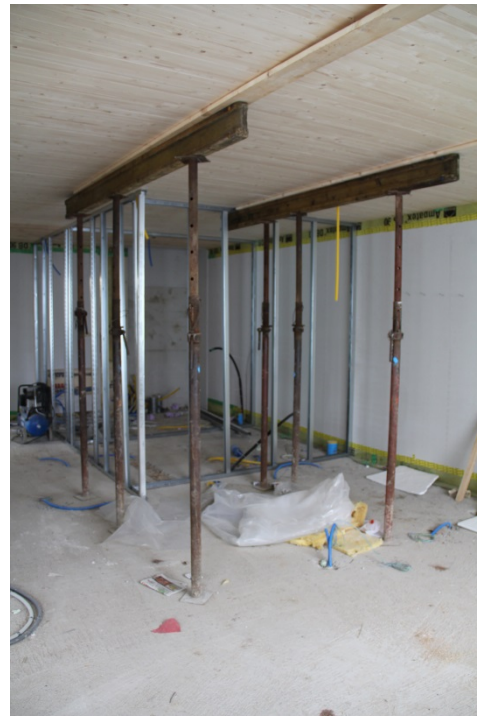
Abbildung 5.2: Abfangung der Gewichtskraft des Schwingungserregers durch Spriessung im EG und im OG 1 während aller 3 Versuchsreihen.
