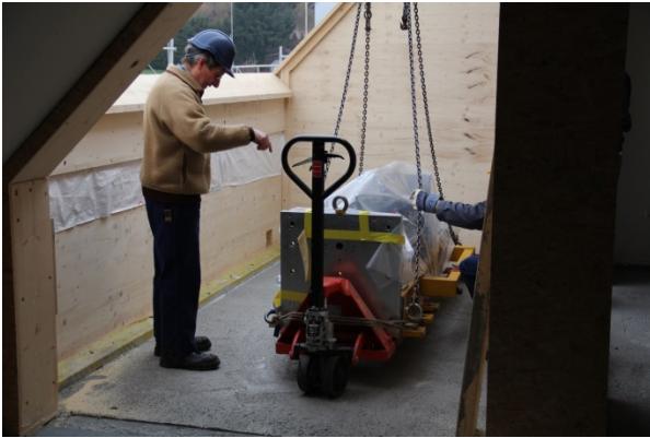
Abbildung 5.11: Schwingungserreger auf Handhubwagen, durch Baustellenkran auf der Balkonplatte abgesetzt.
