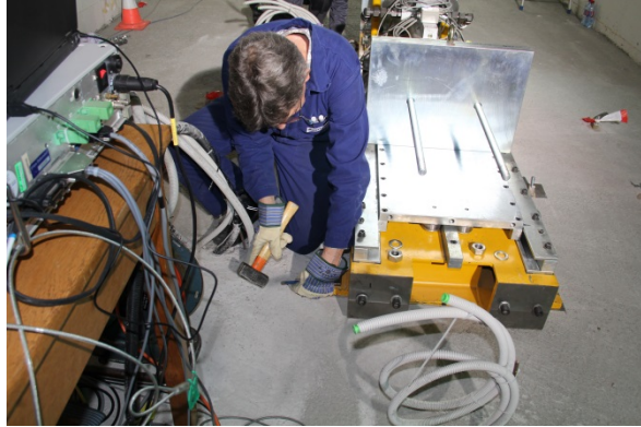
Abbildung 5.18: Lösen der Verankerungsmuttern und Abspitzen des Vergussmörtels.
