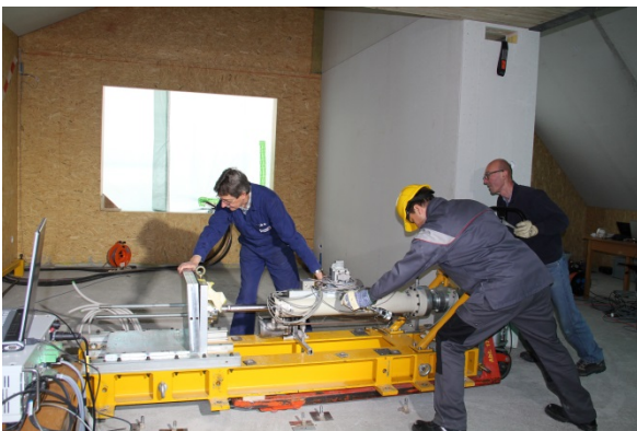
Abbildung 5.21: Drehen des Schwingungserregers im Nebenraum und Positionierung auf den vorbereiteten Ankerstellen.
