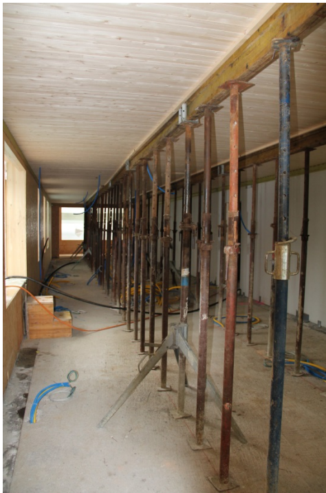
Abbildung 5.1: Abstützung sämtlicher HBV-Decken durch Spriessung im EG und im OG 1 während den Versuchsreihen 1 und 2.
