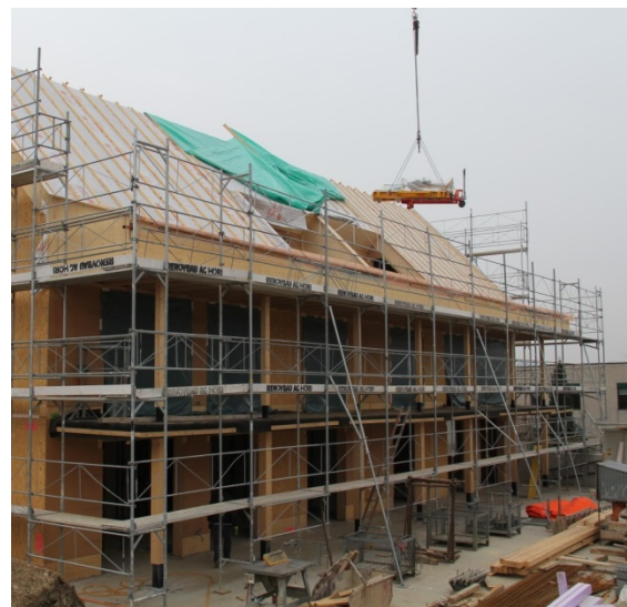
Abbildung 5.10: Einheben des Schwingungserregers (samt Handhubwagen) durch eine der Balkonöffnungen im Dach auf der Nordwestseite des Gebäudes.
