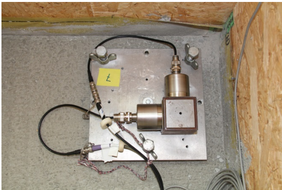
Abbildung 5.26: Messstelle Nr. 7 (Beispiel für OG 1 und OG 2) mit montierten Beschleunigungssensoren PCB 393B31 (horizontal)
