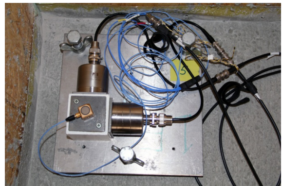
Abbildung 5.27: Messstelle Nr. 5 mit montierten Beschleunigungssensoren PCB 393B31 (horizontal) und PCB 356B18 (vertikal)
