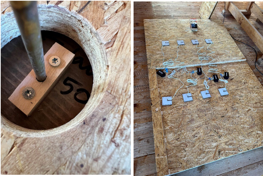
Abbildung 7 Feuchtesensor im Messingrohr in der Fassade, Fassadelement mit einem Holz fixiert
