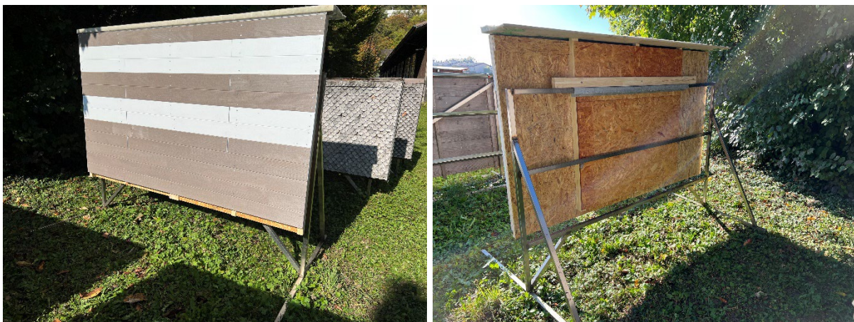
Abbildung 10 Platzierung der Fassadenelemente mit Ausrichtung Süd- Südwest an der Berner Fachhochschule, Vorderansicht links, Hinteransicht rechts (Sensoren sind abgedeckt)
