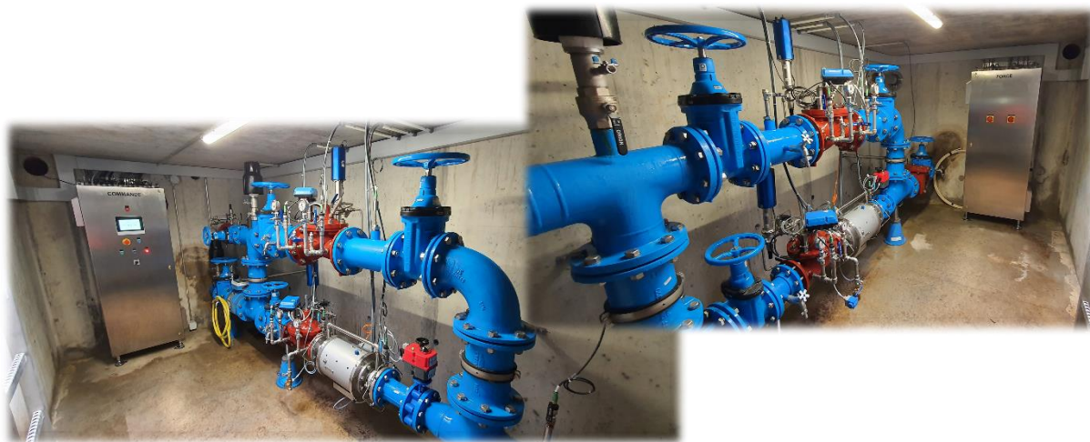
Figure 45 Chambre Verney avec l'ensemble des éléments du système de turbinage après l'installation.
