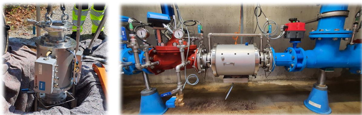
Figure 44: DuoTurbo Verney – introduction dans la chambre de Verney et installation sur la branche de turbinage.
