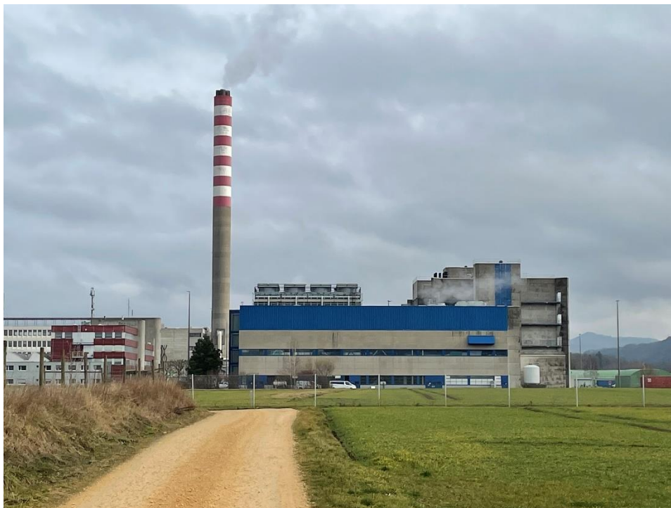
Bild 10: Beim Monitoring des zukünftigen Verbrauchs liegt der Fokus insbesondere auf Grossanlagen > 10 MW Leistung. Im Bild das Holzheizkraftwerk Sisslerfeld in Sisseln AG mit einer Feuerungsleistung von 3 x 35 MW (Bild Holzenergie Schweiz).
