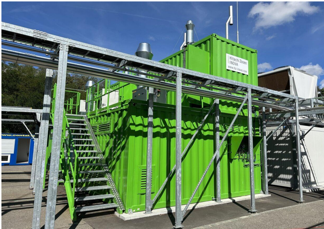
Abbildung 7 Stack und Systemtechnik in KVA Buchs installiert
