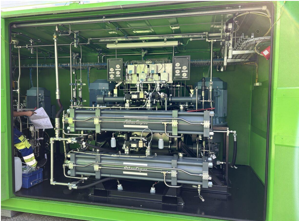
Abbildung 8 Wasserstoff Kompressor in KVA Buchs installiert
