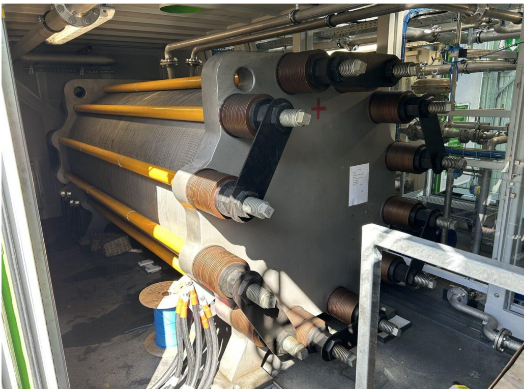
Abbildung 9 Elektrolyse-Stack im Stack und Systemtechnik installiert
