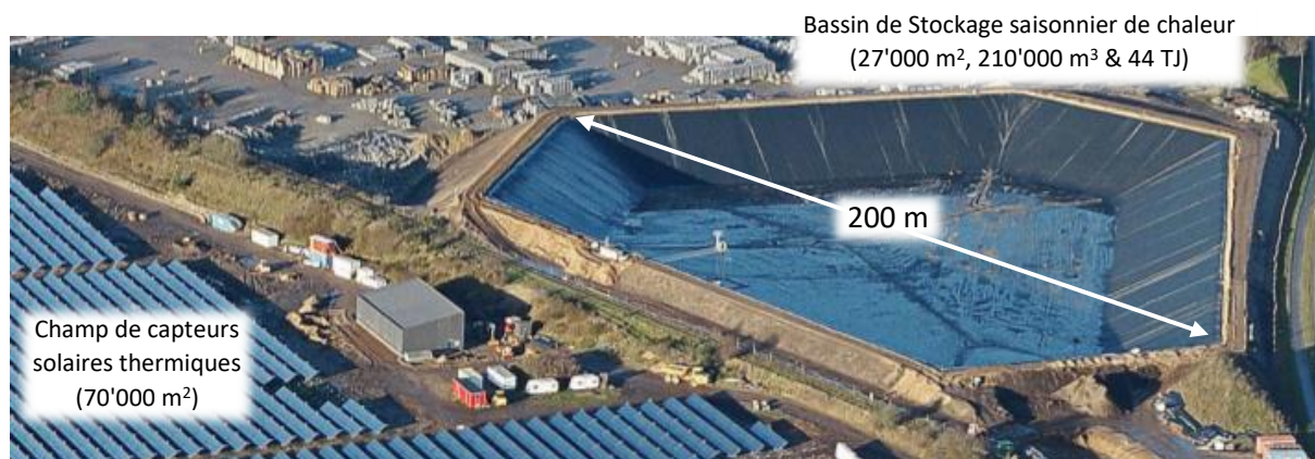
Figure 7.13 : Champs de capteurs solaires thermiques pour le chauffage urbain de Vojens, Danemark, (70'000 m 2 ) à côté du bassin de stockage saisonnier (210'000 m 3 ) en construction en 2014-15 (encore sans la couverture isolante et flottante) (source : http://solarheateurope.eu/2020/05/19/vojens-district-heating/ )
