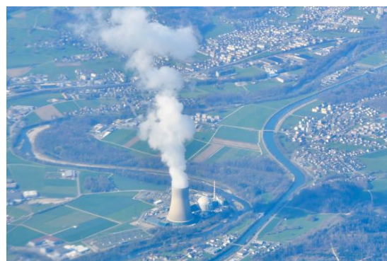
Figure 1.9 : Centrale nucléaire à eau pressurisée (BWR) de Gösgen sur l'Aar (900 MWé) avec son panache de vapeur d'eau (0.75 m 3 /s : 10 millions m 3 d'eau pris sur l'Aar en semestre d'été)
