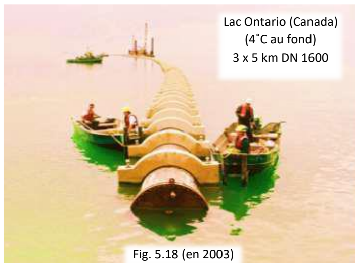
Fig. 5.18 Transport (lac Ontario) de la conduite en PEHD ( \varnothing 1,6 m x 15 km !) de pompage et d'adduction de l'eau du Réseau hydrothermique lacustre de rafraîchissement (DLWC) de la ville canadienne de Toronto (image Enwave)
