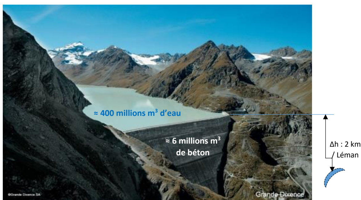
Figure 1.7 : Barrage-poids de la Grand-Dixence, 6 millions m^3 de béton non armé (source : https://www.swissdams.ch )
