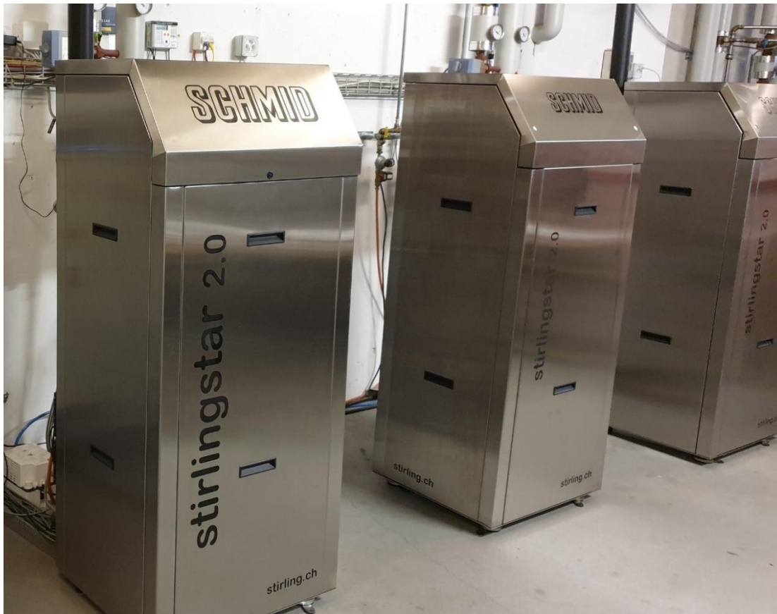
Abbildung 34: Der Freikolben-Resonanzstirling eingebaut im Heizungskeller der Schmid Stirling GmbH, Quelle: Schmid Stirling GmbH, 2022
