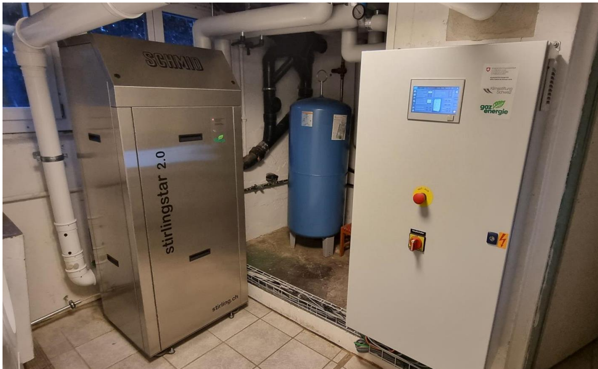
Abbildung 22: Der Freikolben-Resonanzstirling in Biel in einem Zweifamilienhaus eingebaut, Quelle: Schmid Stirling GmbH, 2021
