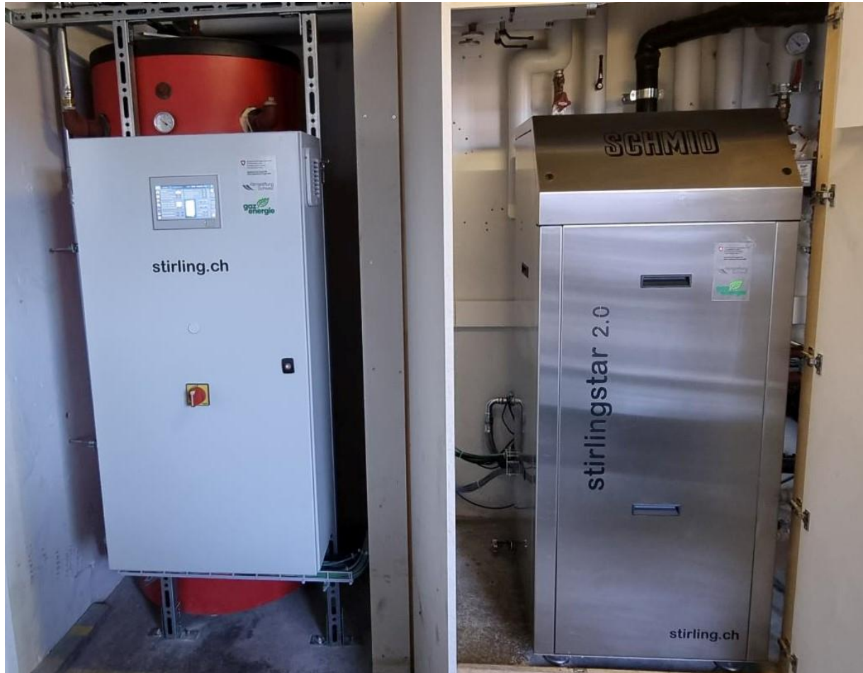
Abbildung 32: Der Freikolben-Resonanzstirling eingebaut in einem Vierfamilienhaus, Quelle: Schmid Stirling GmbH, 2022
