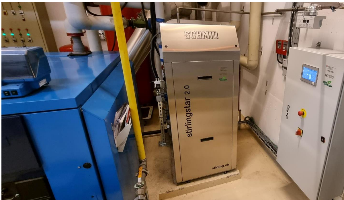
Abbildung 19: Der Freikolben-Resonanzstirling eingebaut im Heizungskeller des lokalen Schwimmbades Plan-les-Ouates, Quelle: Schmid Stirling GmbH, 2022
