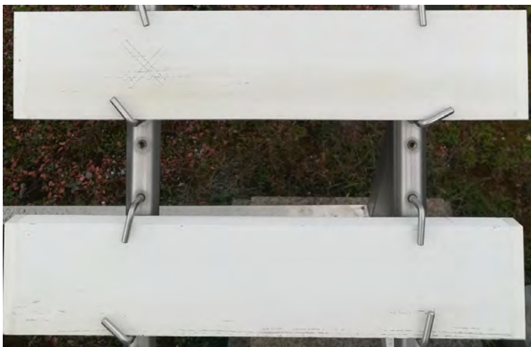
Abbildung 143 Beschichtung 6 nach 1 ½ Jahren Freibewitterung mit deutlich stärkerer Abwitterung und Verfärbung auf den verblauten Bereichen
