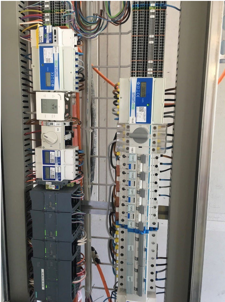
Abbildung 14 Einer von fünf Verteilerkästen zur Unterbringung der Messhardware.
