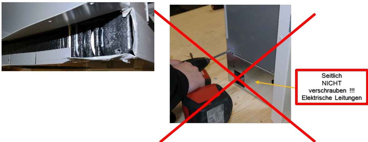
Abbildung 44 Gewonnene Erkenntnisse durch anbohren der Kabelführung eines Lüftungsgeräts.
