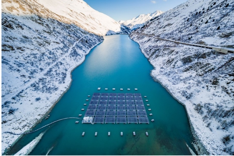
Fig. 18 : Lac de Toulles : Installation photovoltaïque 2019 Lac de Toulles [34]
