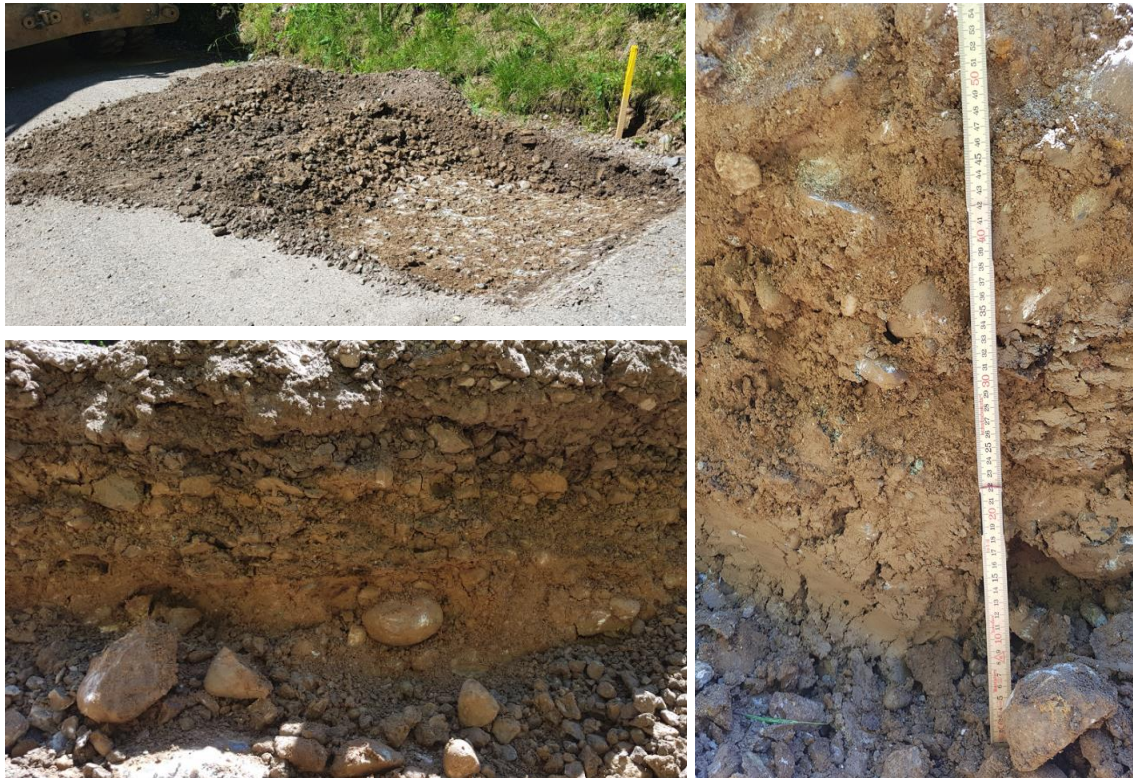
Abbildung 19: Strassenaufbau kürzlich sanierte Strasse im Gebiet mit dem Flurnamen Blueme
