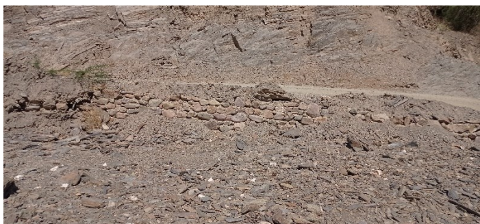
Muro de contención construido para proteger las tuberías del sistema de riego Fotografía: Equipo consultor
