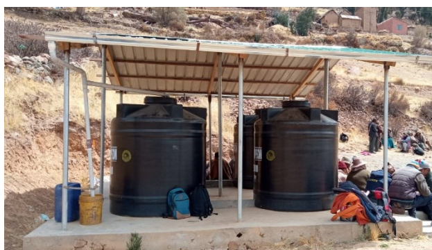
Sistema de cosecha de agua en techo de la comunidad Chejerico Fotografía: Equipo consultor
