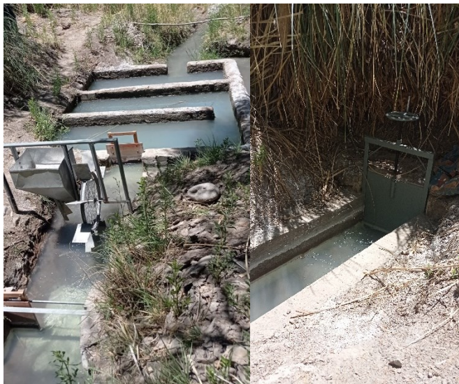
Estanque de floculación para el tratamiento del pH del agua con cal Fotografía: Equipo consultor
