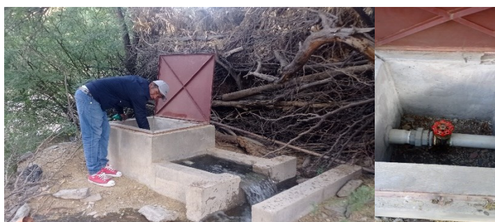
Cámara de distribución de agua de riego habilitada con nuevos accesorios Fotografía: Equipo consultor
