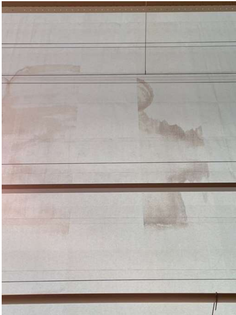
Figure 56 - Photo prise le 19 Décembre 2022, des taches sont visibles sur l'écran Infrascreeen et correspondent à des défauts dans la déposition du top coat. Ces taches sont contingentées sur des largeurs de 500 mm et des longueurs de +/- 6,0 m ce qui correspond bien au problème rencontré lors de la dépose du top coat.
