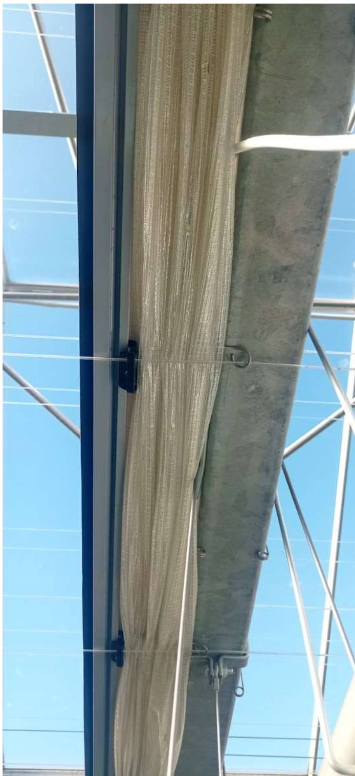
Figure 58 – Photo d'un écran plié, 5,20 m d'écran sont réduit en un "paquet" de 10 cm. On aperçoit également les câbles de soutien au-dessous et en-dessous de l'écran.
