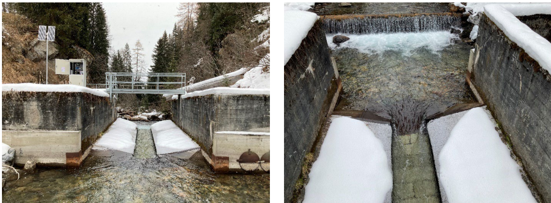
Abbildung 1: Messstation am Dischmabach bei niedrigem Abfluss im Winter; links: Blick von oberhalb der Messstation in Fließrichtung; rechts: Blick von der Brücke aus nach stromaufwärts auf den Zulaufbereich und die Schwelle. Quelle: BAFU
