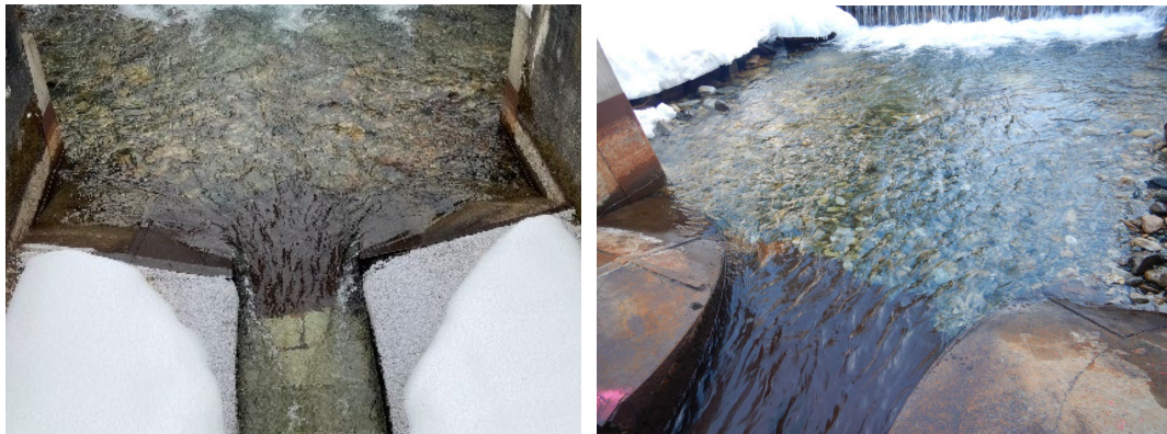
Abbildung 16: Strömung beim Übergang vom Zulaufbereich zur Niedrigwasserrinne für Szenario Vormittag (links) und Szenario Nachmittag nach Räumung des Gerölls (rechts). Quelle: BAFU und M. Margreth
