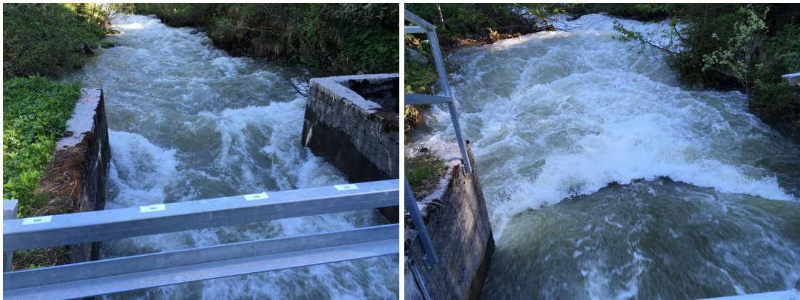
Abbildung 35: Abflussverhältnisse an der Messtation Dischmabach am 13.06.2019 bei einem Abfluss von 9'870 l/s: links Zulaufbereich und rechts Unterwasser. Foto: A. Kohler, BAFU
