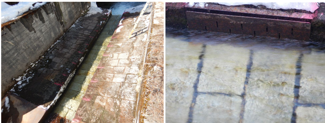
Abbildung 36: Gepflasterte Sohle in Niedrigwasserrinne (Foto vom 14.03.2022, M. Margreth & R. Kaderli)
