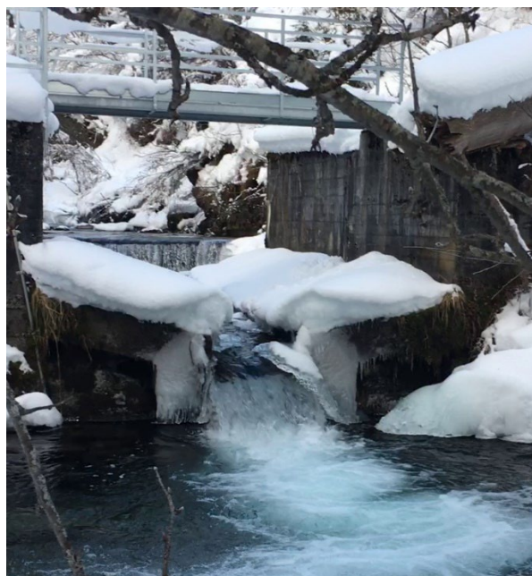
Abbildung 2: Messstation am Dischmabach bei niedrigem Abfluss im Winter; Blick von unterhalb der Messstation. Quelle: M. Margreth
