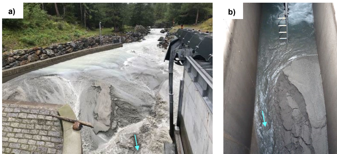
Abbildung 39: a) Stark verlandetes Staubecken nach dem Hochwasser 2014 (Foto: OESS) und b) Blick von oben in eine Entsanderkammer auf den Hochpunkt der Sedimentablagerungen (09.07.2019, Foto: VAW) jeweils am Beginn einer Spülung.
