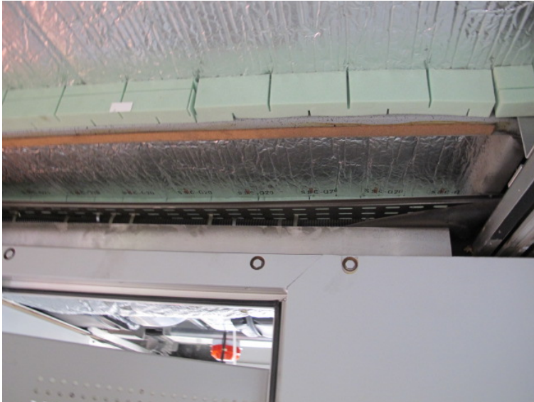
Abbildung 70. Dach bei Führerstands-Türe im Hochflurabteil von Endwagen ET1 bei demontiertem Decken-Lüftungskanal. Bei Dachspiegel Wärmedämmung Q1 30 mm sowie bei Fläche zwischen den Dachspiegeln zweite Lage mit Wärmedämmung Q20 6 mm sichtbar. Am Dach über den Apparateschränken und über dem Führerstand verbleibt dort die bisherige Wärmedämmung MONIFLEX. Wegen hohem Arbeitsaufwand für Demontage der Apparateschränke wird dort keine neue Wärmedämmung für Dachspiegel und Dachfläche montiert. Foto: ECOTRANS Peter Wüst, 14.11.2017.
