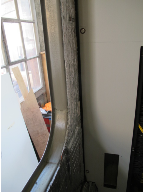
Abbildung 74. Ecke des Seitenfensters beim Führerstand des Endwagens ET1. Seitenwand mit durchgehend überdeckender Wärmedämmung Q20 6 mm. Es fehlt die Wärmedämmung Q20 6 mm des Stahlrahmens, die bei allen Seitenfenstern der drei Wagenkasten ET1, ET2 und AB nicht montiert wurde. Foto: ECOTRANS Peter Wüst, 14.11.2017.
