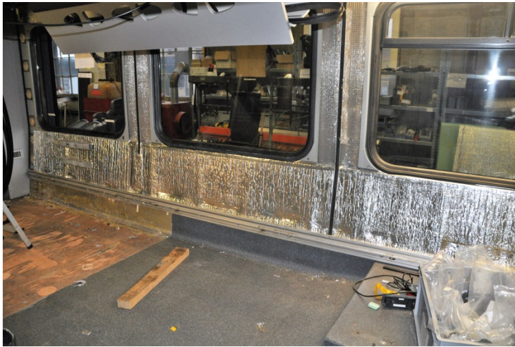
Abbildung 21. Wärmedämmung als partieller Vorversuch an der rechten Seitenwand des Mittelwagens B vom Triebzug RABe 525 NINA 003. Ansicht mit durchgehender Deckschicht Q20 6 mm über allen Varianten der Wärmedämmung. Foto: ECOTRANS Peter Wüst 12.01.2017.
