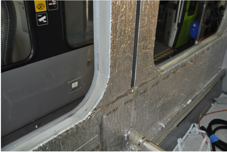
Abbildung 82. Fertige Wärmedämmung der Seitenwand im Hochflurabteil des Endwagens ET1, mit Detail der Wärmedämmung bei Füllrohr des Sanderbehälters. Foto: Renato Gartner, 14.11.2017.
