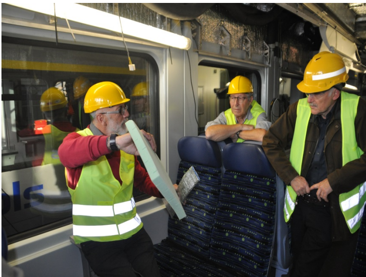
Abbildung 36. Besprechung der fertigen Wärmedämmung im Triebzug RABe 525 NINA 005, mit ECOTRANS Peter Wüst (links), SSC Ernst Fehr (Mitte) und BAV Stefan Schnell (rechts). Foto: Renato Gartner, 14.11.2017.
