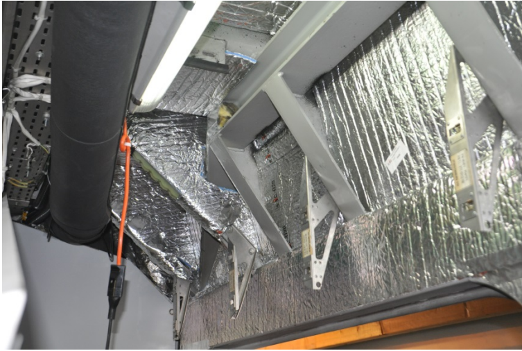
Abbildung 80. Aufwendige Wärmedämmung ohne vorgefertigte Zuschnitte bei den Abstützungen des Haupttransformators an der Decke des Endwagens ET1. Foto: Renato Gartner, 14.11.2017.
