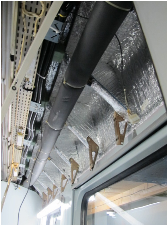
Abbildung 75. Bereich zwischen Seitenwand und Dach beim Endwagen Et2, nahe dem WC. Fertige Wärmedämmung der Seitenwand und der Dreieck-Spicket. Foto: ECOTRANS Peter Wüst, 14.11.2017.
