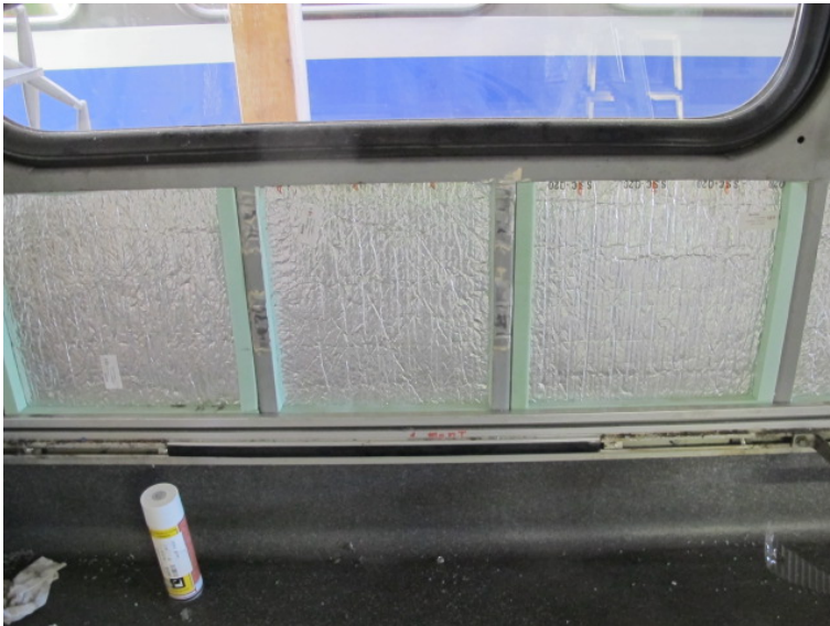
Abbildung 61. Wärmedämmung der Seitenwand. Die erste Lage der Wärmedämmung Q1 30 mm ist mit der zweiten Lage alubeschichteter Wärmedämmung Q20 6 mm überdeckt. Die vertikalen Z-Profile sind mit Wärmedämmung Q1 30 mm isoliert. Die durchgehende Deckschicht mit der Wärmedämmung Q20 6 mm ist noch nicht montiert. Foto: ECOTRANS Peter Wüst, 13.10.2017.
