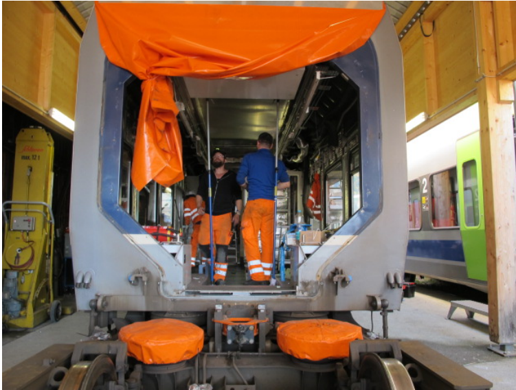
Abbildung 56. Endwagen ET2 kurz vor Demontage des Decken-Lüftungskanals. Vor dem Ausbohren der seitlichen Befestigungsnieten ist der Decken-Lüftungskanal bereits mit Spliessen abgestützt. Foto: ECOTRANS Peter Wüst, 12.10.2017.
