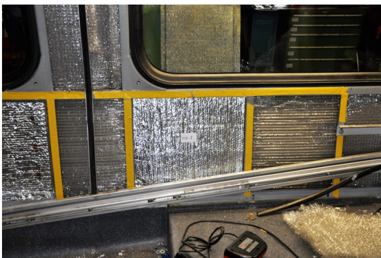
Abbildung 16. Wärmedämmung Variante 2 als partieller Vorversuch an der rechten Seitenwand des Mittelwagens B vom Triebzug RABe 525 NINA 003. Ansicht noch ohne durchgehende Deckschicht Q20 6 mm. Foto: ECOTRANS Peter Wüst 12.01.2017.
