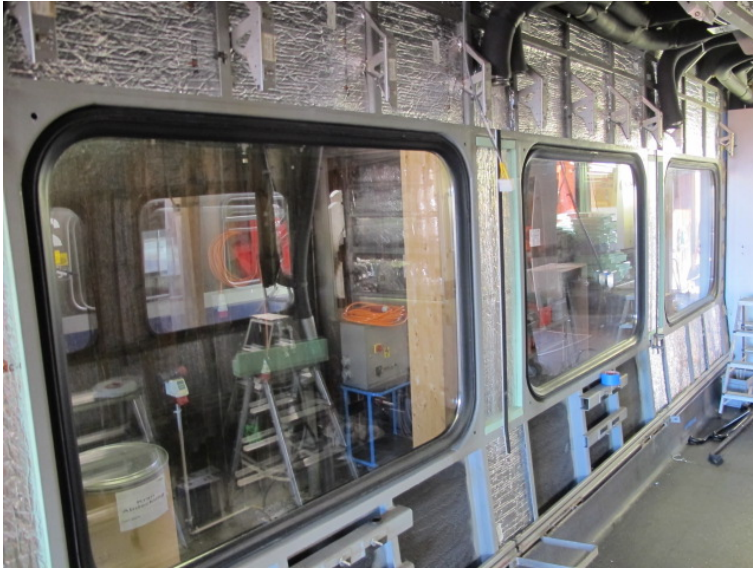
Abbildung 60. Seitenwand teilweise mit neuer Wärmedämmung. Die bisherigen Halterungen der Seitenwandtische sind noch nicht demontiert. Foto: ECOTRANS Peter Wüst, 13.10.2017.
