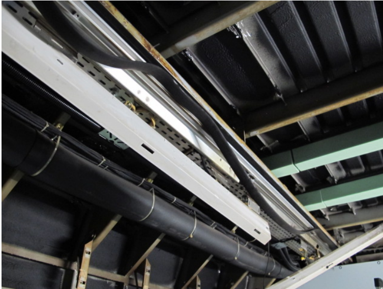
Abbildung 64. Bereich zwischen Seitenwand und Dach im Niederflrabteil von Endwagen ET2 beim Wagenübergang, vor Montage der Wärmedämmung, bei bereits demontiertem Decken-Lüftungskanal. Abluftrohr des WC (mit schwarzer Dämmung), befestigt mit Kabelbindern an den Dreieck-Spickeln. Foto: ECOTRANS Peter Wüst, 20.10.2017.
