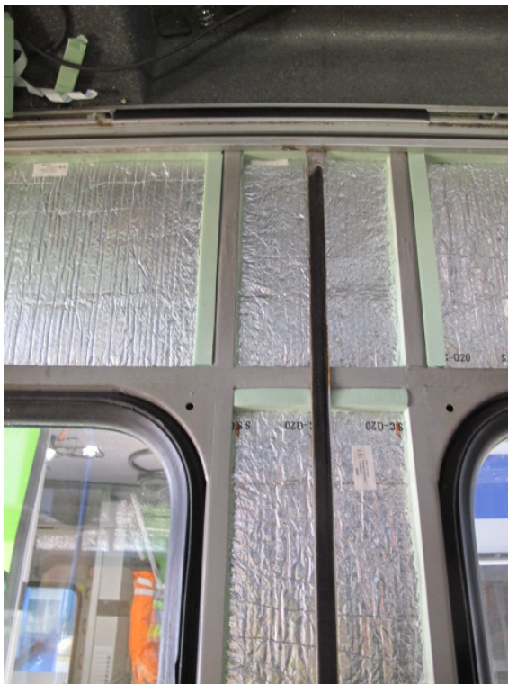
Abbildung 54. Wärmedämmung der Seitenwand. Die erste Lage der Wärmedämmung Q1 30 mm ist mit der zweiten Lage alubeschichteter Wärmedämmung Q20 6 mm überdeckt. Die horizontalen und vertikalen Z-Profile sind mit Wärmedämmung Q1 30 mm isoliert. Die durchgehende Deckschicht mit der Wärmedämmung Q20 6 mm ist noch nicht montiert. Foto: ECOTRANS Peter Wüst, 12.10.2017.
