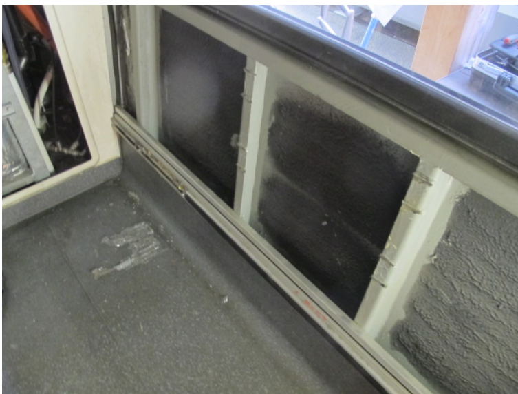
Abbildung 51. Seitenwand im Endwagen ET2 beim WC unter Fenster nach Demontage der bisherigen Wärmedämmung MONIFLEX sowie nach Entfernung der bisherigen Halterungen für die Seitenwand-tische. Foto: ECOTRANS Peter Wüst, 12.10.2017.
