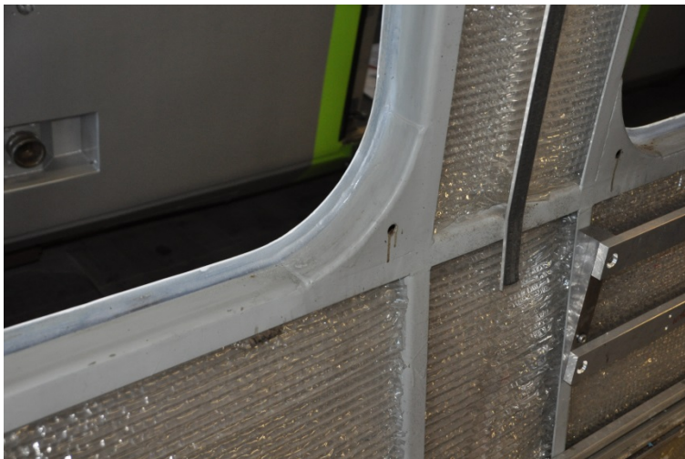
Abbildung 11. Wärmedämmung der Seitenwand, Variante 0 (Ist-Zustand). Wärmedämmung MONIFLEX zwischen den Seitenwandrippen des Fahrgastraums von RABe 525 NINA 002. Die Innenflächen der Seitenwandrippen sind nicht gedämmt. Foto: ECOTRANS Peter Wüst, 19.11.2015.
