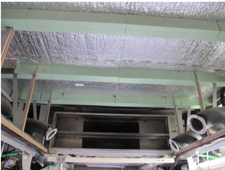
Abbildung 73. Dach im Niederflurabteil von Endwagen ET1 bei demontiertem Decken-Lüftungskanal. Beide Ausblasöffnungen der Lüftungsgruppe sichtbar. Bei Dachspriegel Wärmedämmung Q1 30 mm sowie bei Fläche zwischen den Dachspriegeln zweite Lage mit Wärmedämmung Q20 6 mm sichtbar. Bei der Wärmedämmung der Dachspriegel sind die Durchführungen für die drei in Wagen-Längsrichtung verlaufenden Stahldrähte zur Befestigung der Wärmedämmung erkennbar. Foto: ECOTRANS Peter Wüst, 14.11.2017.
