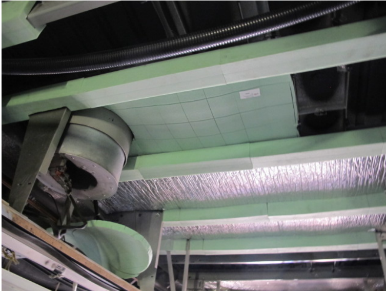
Abbildung 62. Dach bei Abluftventilator des Endwagens ET2. Die Dachspriegel sind mit vorgefertigter Wärmedämmung aus Q1 30 mm isoliert. Zwischen den Dachspriegeln ist die erste Lage der Wärmedämmung Q1 30 mm (grün) respektive bereits der zweiten Lage mit der alubeschichteten Wärmedämmung Q20 6 mm erkennbar. Foto: ECOTRANS Peter Wüst, 13.10.2017.
