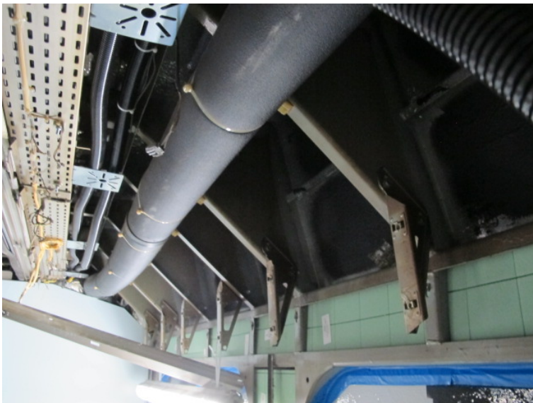
Abbildung 63. Bereich zwischen Seitenwand und Dach im Niederflurabteil von Endwagen ET2 beim WC, vor Montage der Wärmedämmung. Enge Platzverhältnisse durch Kabeltrasse sowie Abluftrohr des WC (mit schwarzer Dämmung), befestigt mit Kabelbindern an den Dreieck-Spickeln. Foto: ECOTRANS Peter Wüst, 20.10.2017.
