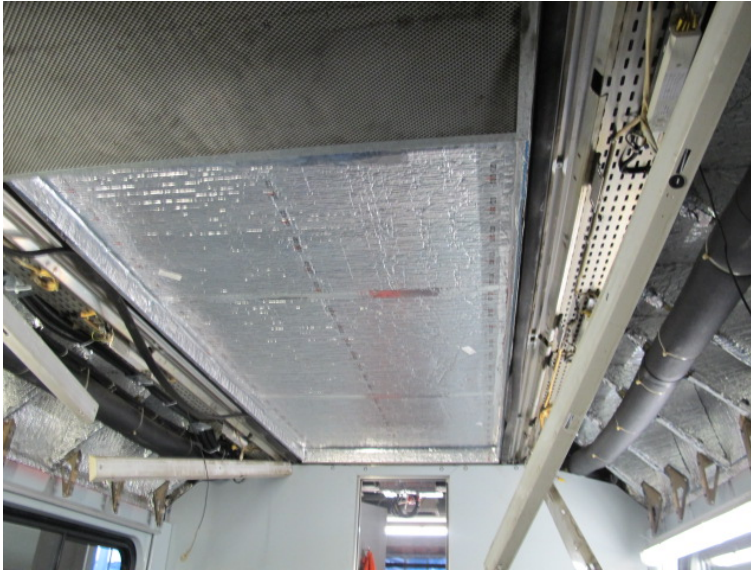
Abbildung 76. Decke im Hochflurabteil von Endwagen ET2 bei Führerstands-Türe, mit montiertem Decken-Lüftungskanal. Bei den Innenflächen des Decken-Lüftungskanals erfolgt der Ersatz der bisherigen Wärmedämmung mit Mineralwollmatten durch Wärmedämmung Q20 6 mm. Dies ist bereits Bestandteil des Refit-Arbeitsumfangs bei allen 36 Zügen Rabe 525 NINA, unabhängig von der Verbesserung der Wärmedämmung. Foto: ECOTRANS Peter Wüst, 14.11.2017.
