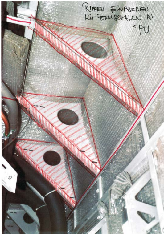
Abbildung 24. Isolation der Verstärkungs-Dreiecke zur Versteifung von Decken- und Seitenwandrippen im Dachbereich mit Formteilen. Foto und Skizze R. Gartner.
