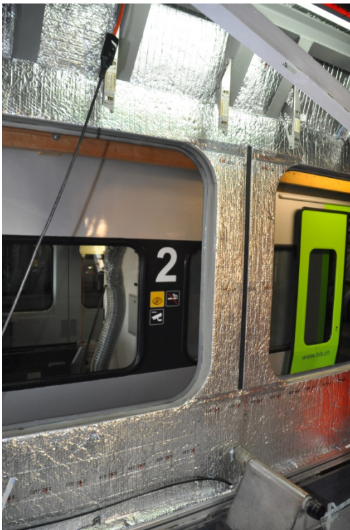
Abbildung 81. Fertige Wärmedämmung der Seitenwand im Hochflurabteil des Endwagens ET1. Foto: Renato Gartner, 14.11.2017.
