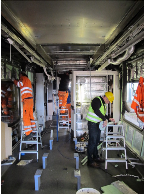
Abbildung 30. Montage der Wärmedämmung an den Seitenwänden im Endwagen ET2 von RABe 525 NINA 005. An der Decke ist der Lüftungskanal noch nicht demontiert. Foto: ECOTRANS Peter Wüst, 13.10.2017.
