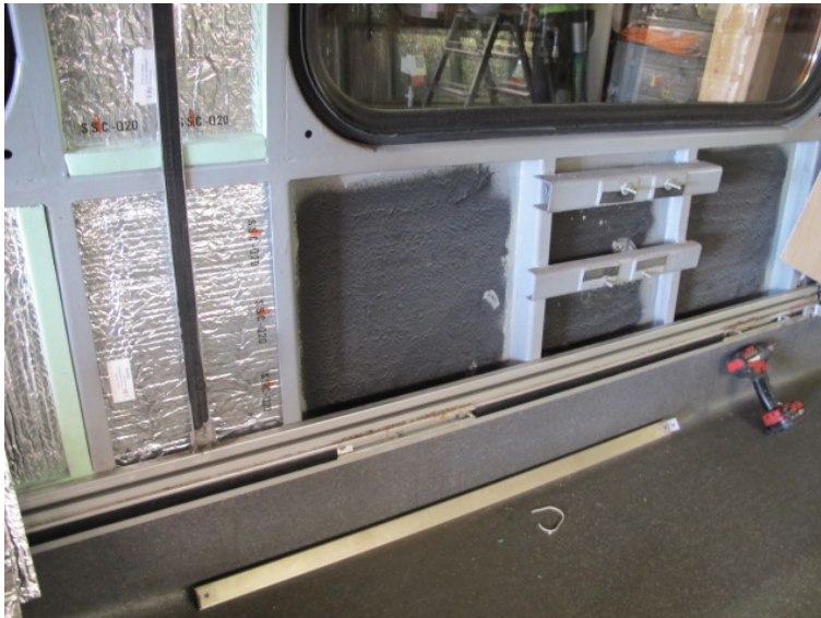
Abbildung 55. Wärmedämmung der Seitenwand (links). Die bisherigen Halterungen der Seitenwandstruktur sind noch nicht entfernt. Foto: ECOTRANS Peter Wüst, 12.10.2017.
