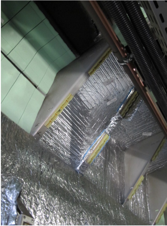
Abbildung 66. Bereich zwischen Seitenwand und Dach mit neuer Wärmedämmung. Flächen zwischen Dreieck-Spickeln mit erster Lage der Wärmedämmung Q1 30 mm (grün) und teilweise bereits mit zweiter Lage alubeschichteter Wärmedämmung Q20 6 mm isoliert. Dreieck-Spickel zwischen Seitenwandprofil und Dachspriegel mit alubeschichteter Wärmedämmung Q20 10 mm isoliert. Die Anschläge der Deckenverkleidung (beige) sind aus der Wärmedämmung Q20 10 mm ausgeschnitten. Foto: ECOTRANS Peter Wüst, 20.10.2017.
