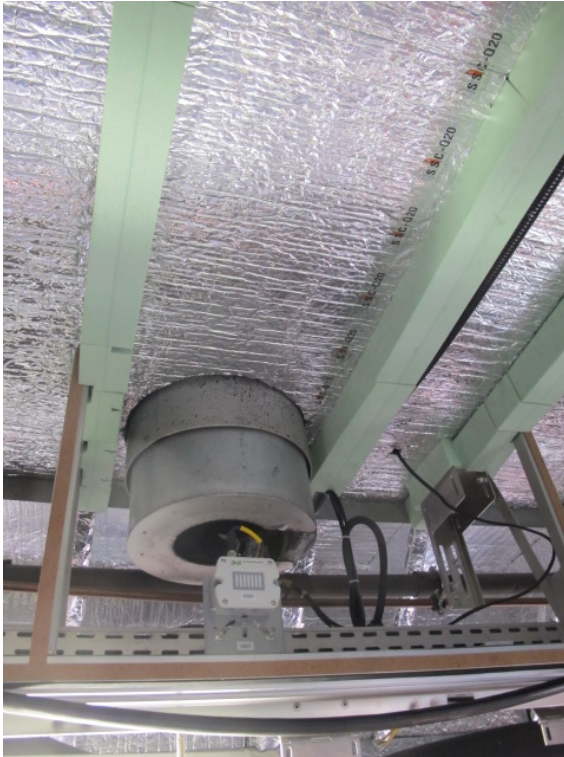
Abbildung 72. Dach bei Abluftventilator des Endwagens ET1. Die Dachspriegel sind mit vorgefertigter Wärmedämmung aus Q1 30 mm isoliert. Zwischen den Dachspriegeln ist die zweite Lage alube-schichteter Wärmedämmung Q20 6 mm erkennbar. Foto: ECOTRANS Peter Wüst, 14.11.2017.
