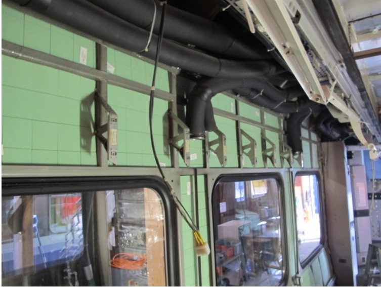
Abbildung 50. Seitenwand mit erster Lage von Dämmmaterial SSC Q1 30 mm. Foto: ECOTRANS Peter Wüst, 12.10.2017.
