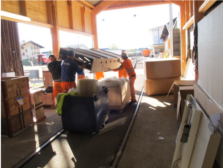
Abbildung 58. Demontierter Decken-Lüftungskanal aus Niederflur-Abteil von Endwagen ET2. Foto: ECOTRANS Peter Wüst, 12.10.2017.
