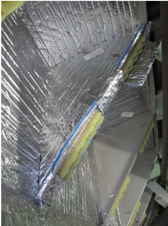
Abbildung 31. Verwendung von vorgeschnittener Wärmedämmung. Die erkennbaren Etiketten erlauben eine rasche Identifikation und Positionierung der verschiedenen Teile. Foto: ECOTRANS Peter Wüst, 13.10.2017.
