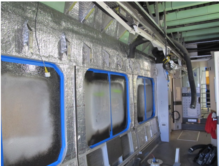
Abbildung 65. Seitenwand und Dach teilweise mit neuer Wärmedämmung. Die bisherigen Halterungen der Seitenwandtische sind bereits demontiert. Foto: ECOTRANS Peter Wüst, 20.10.2017.
