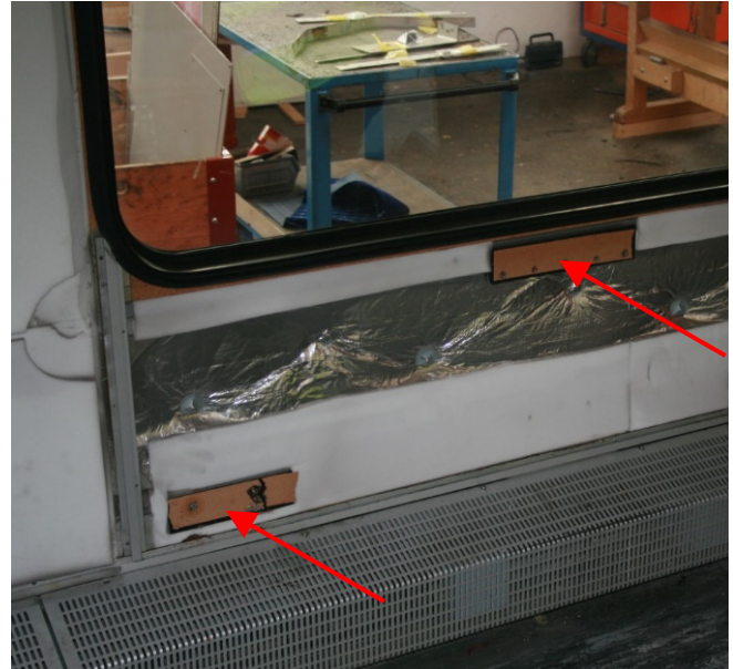
Abbildung 20: Wärmebrücken mit Korkstreifen abgedeckt
