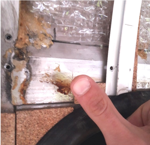
Abbildung 19: Wärmebrücke Seitenwandkonstruktion
