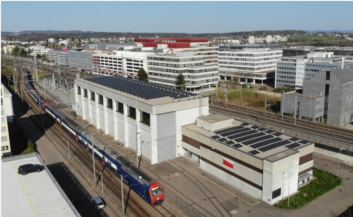
Abbildung 3: Photovoltaikmodule auf dem Dach des Umformergebäudes (links) und des Dienstgebäudes (rechts) des SBB Energie Standortes Zürich Seebach [Foto: Basler & Hofmann AG, Christof Bucher].
