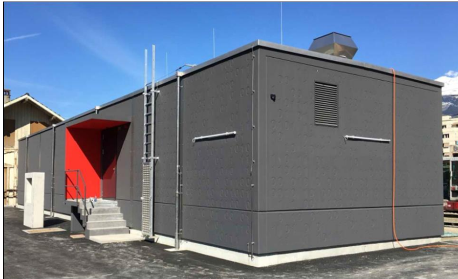
Illustration 5: Vue extérieure réelle du type de bâtiment ferroviaire «Netstal» modélisé.
