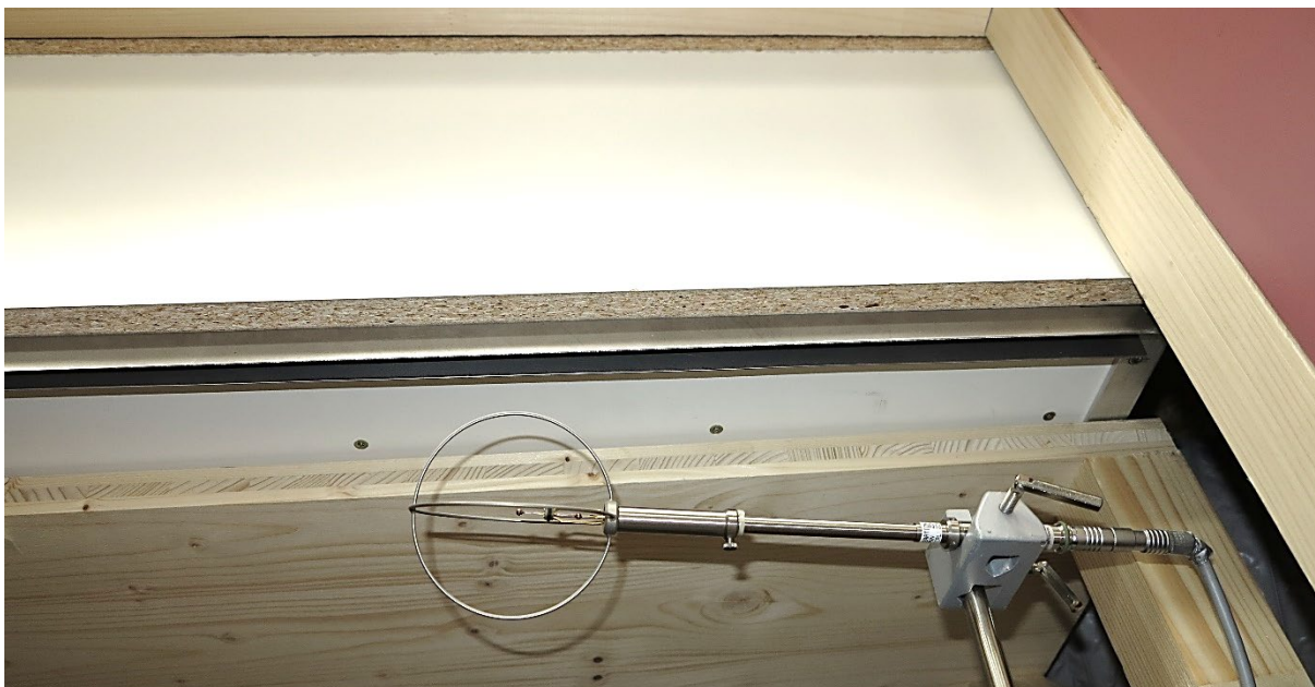
Abbildung 20 Einbausituation Schlitzauslass TLS2
