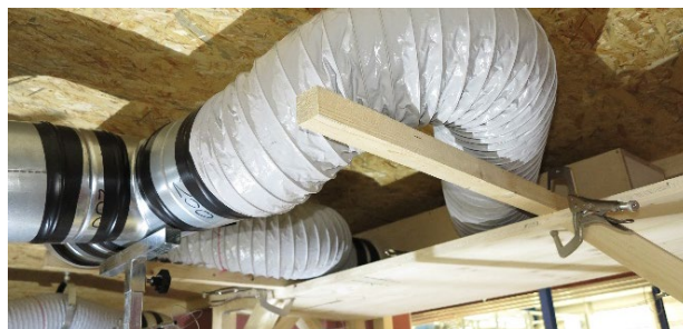
Abbildung 24 Anschluss der Zuluft der TLS-Box
