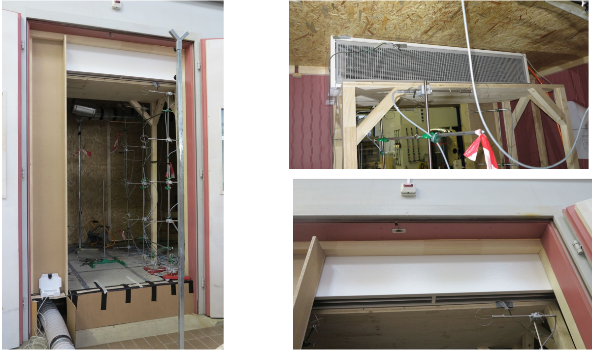
Abbildung 15 Bilder vom Einbau des Türluftschleiers TLS1
