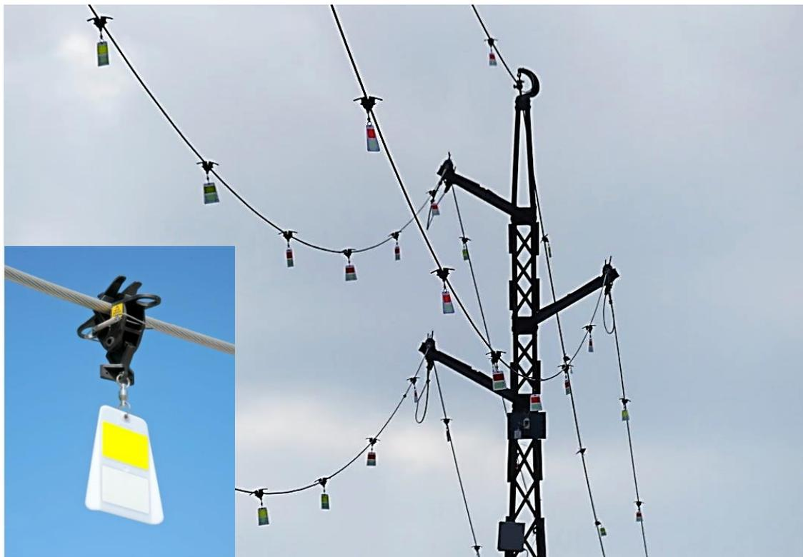
Figure 5 : Balise de type « FireFly » et câbles équipés fin 2020 au Fanel
