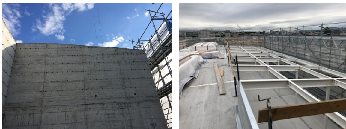
Fig. 2: La structure métallique est donc inclinée pour les pans destinés à l'installation photovoltaïque et plat sur la zone centrale destinées aux installations techniques.
