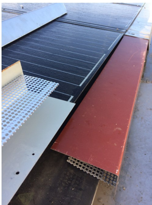
Fig. 9: Éléments de délimitation métalliques de l'interface de la gouttière.
