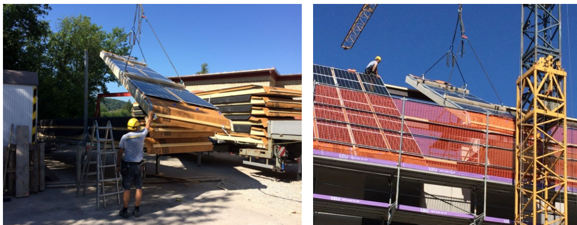
Fig. 8: Installation des « superélément » (exemple)
