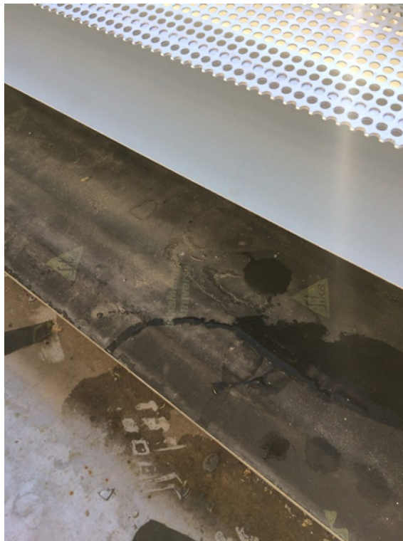
Fig. 10: Interface de gouttière : eau stagnante.
