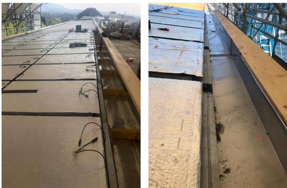
Fig. 5: Les modules sont ensuite fixés au lambourdages et raccordés selon leur chaîne défini par l'ingénieur chargé du projet (Greenkey)
