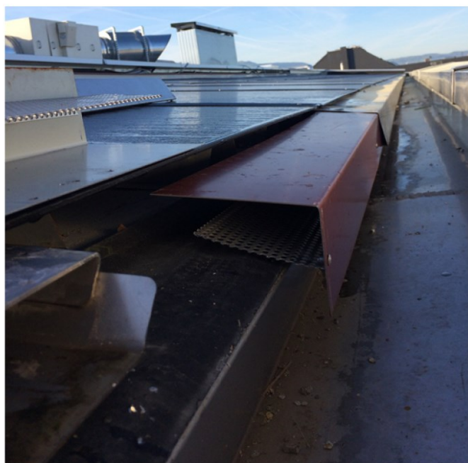
Fig. 9: Éléments de délimitation métalliques de l'interface de la gouttière.
