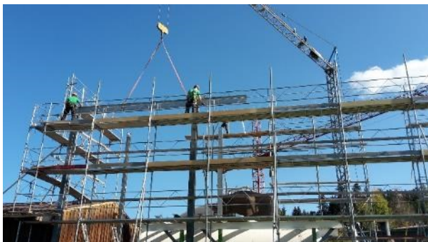
Die Stahlhalle wird in 11 m Höhe aufgerichtet.
