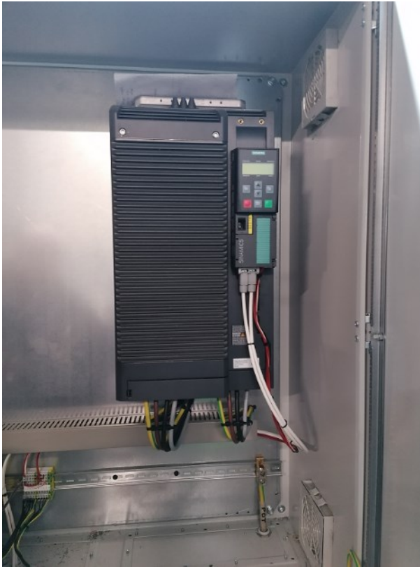
Der Frequenzumformer für den Schredder ist montiert.
