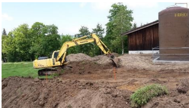
Baustart: Hier wird gerade mit dem Abhumusieren begonnen.
