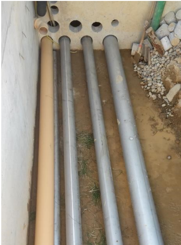
Druck und Saugleitungen werden im Boden verlegt.
