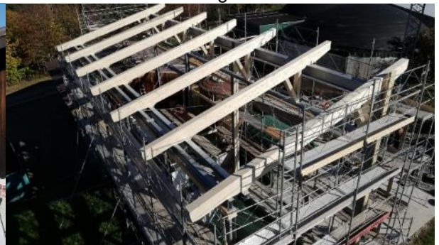
Die Dachbinder mit integrierter Kranschiene werden montiert.
