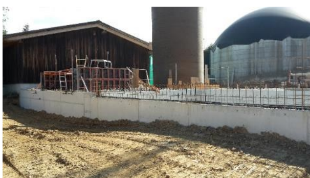
Die Seitenwände des Gebäudes werden geschalt.
