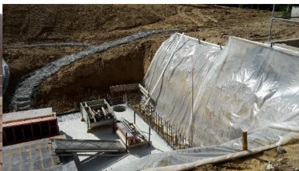
Die Bodenplatte des Bunkers ist gemacht, nun beginnt das Schalen der Seitenwände.
