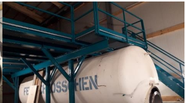
Geländer und Treppe für das Podest werden konstruiert und montiert.
