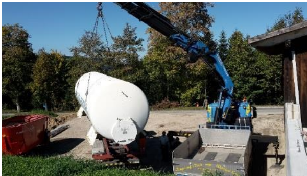
Der Vormischbehälter wird mit einem LKW-Kran an seinen zukünftigen Arbeitsplatz gehievt.
