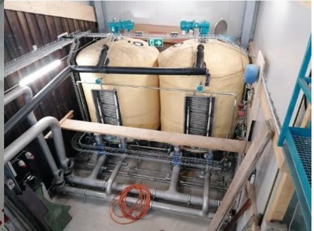
Die Hygienisierungstanks werden gestellt und angeschlossen.
