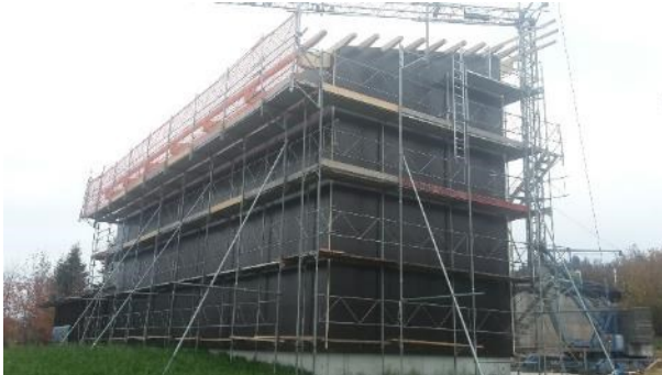
Die Fassade und das Dach mit Sandwichblech werden montiert.
