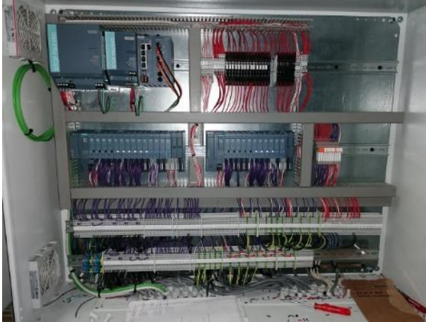
Verdrahtungsarbeiten eines Peripherie-schrankes für Steuerung und Sensorik werden durch-
