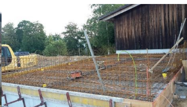
Die Bodenplatte der Halle ist armiert, der Beton wird in Kürze angeliefert.
