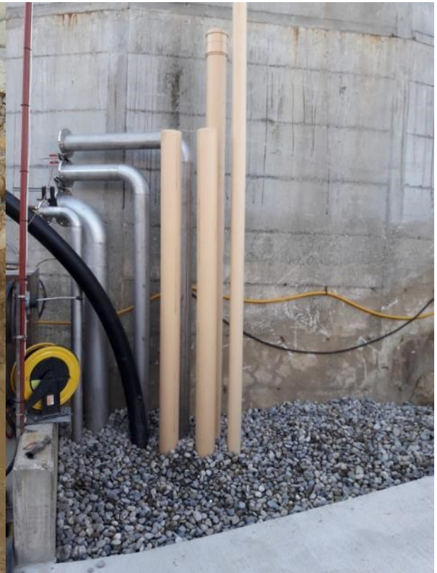
Die Versorgungsleitungen ragen aus dem Boden. Ersichtlich sind: Druck-, Saug-, Strom-, Luft- und Reserveleitungen.
