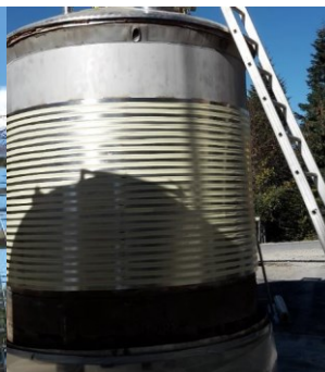
Die Druckprüfung des 1. Hygienisierungstanks wird durchgeführt.
