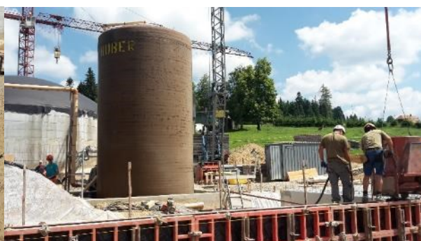
Die Seitenwände des Gebäudes werden betoniert.
