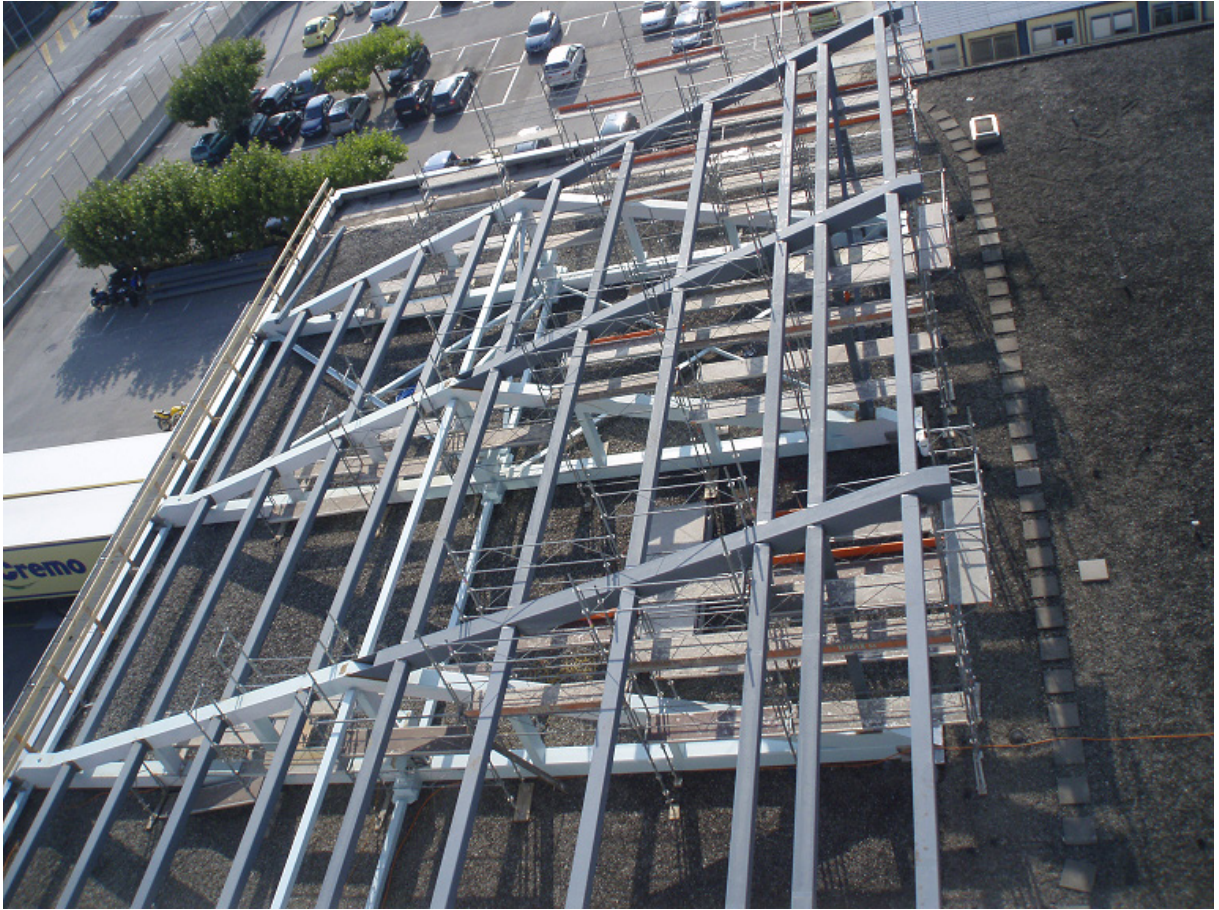
Montage de la charpente métallique
