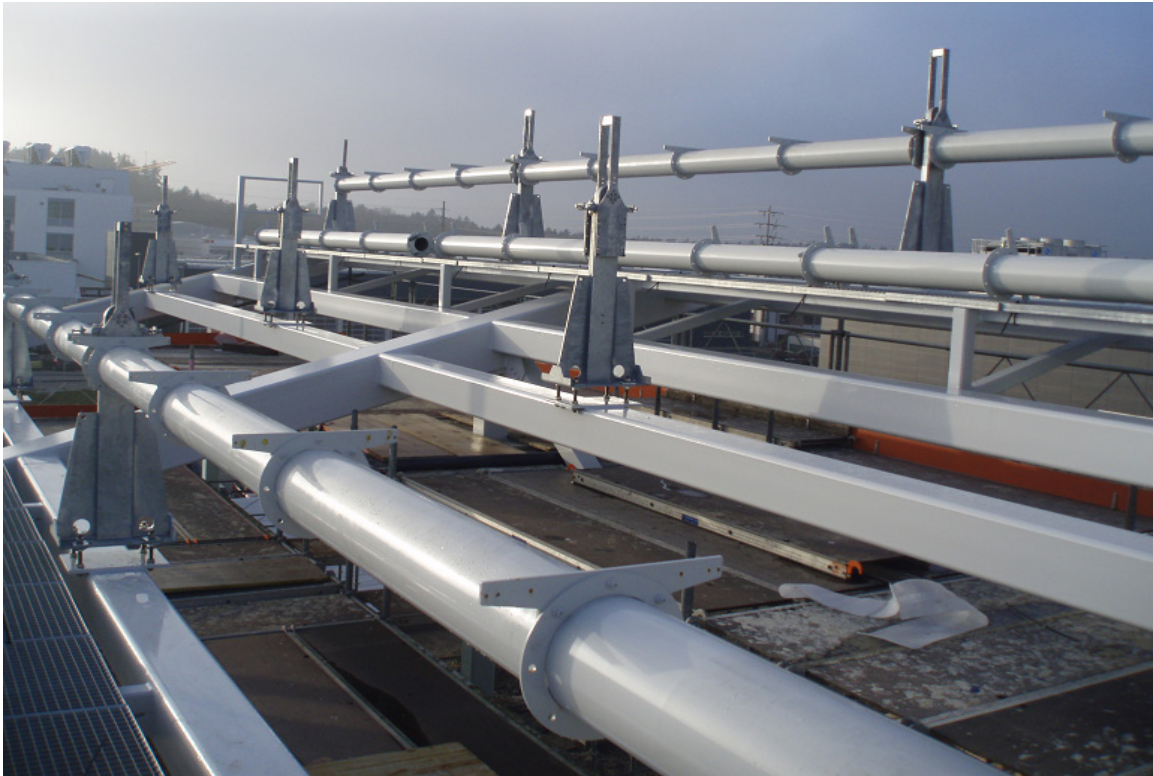
Montage des supports des collecteurs paraboliques
