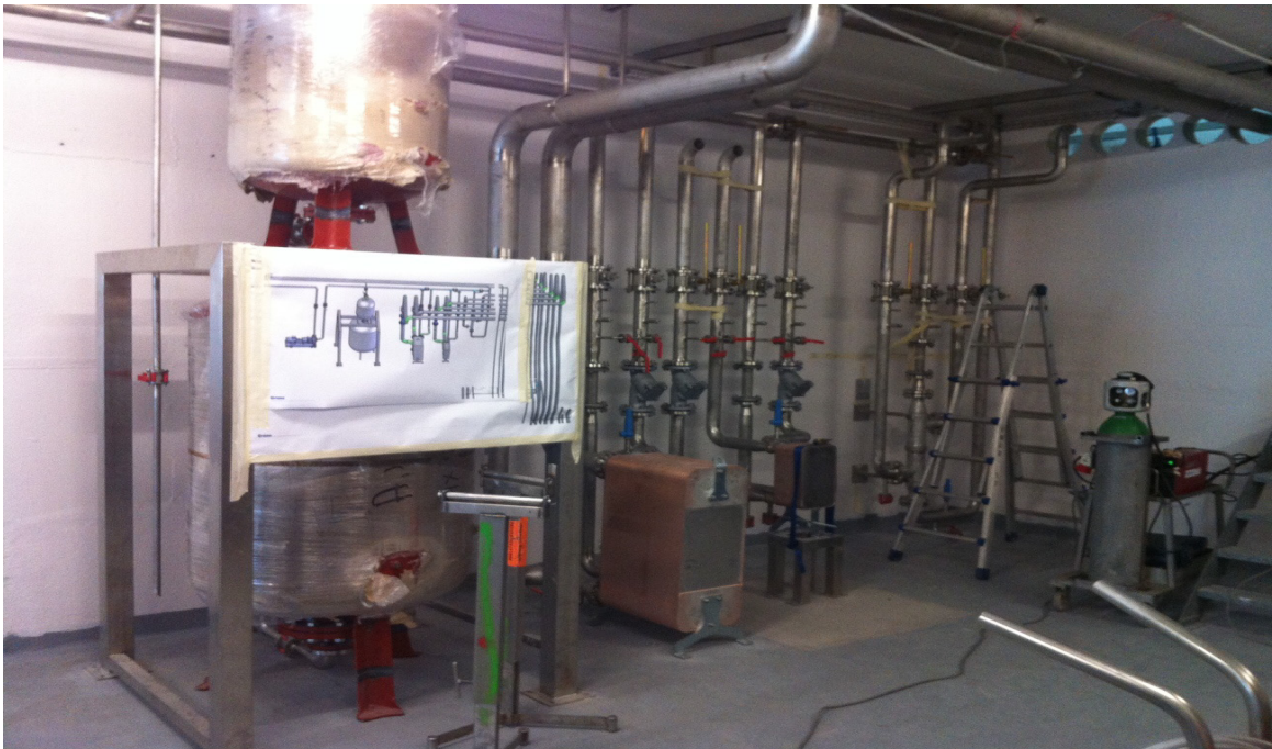
Le système d'échangeurs permettant la récupération de l'énergie en cours de réalisation
