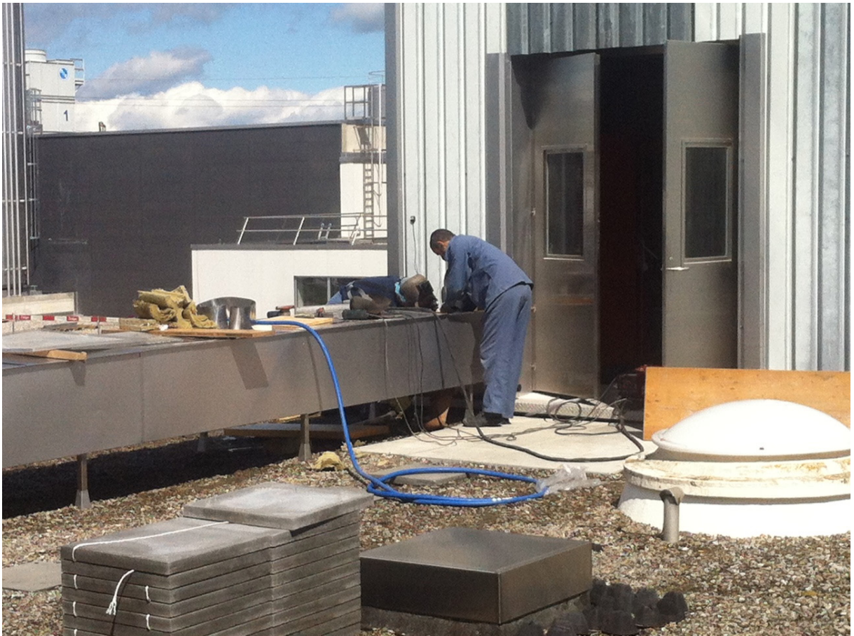
Gaine technique contenant les conduites de transport d'énergie
