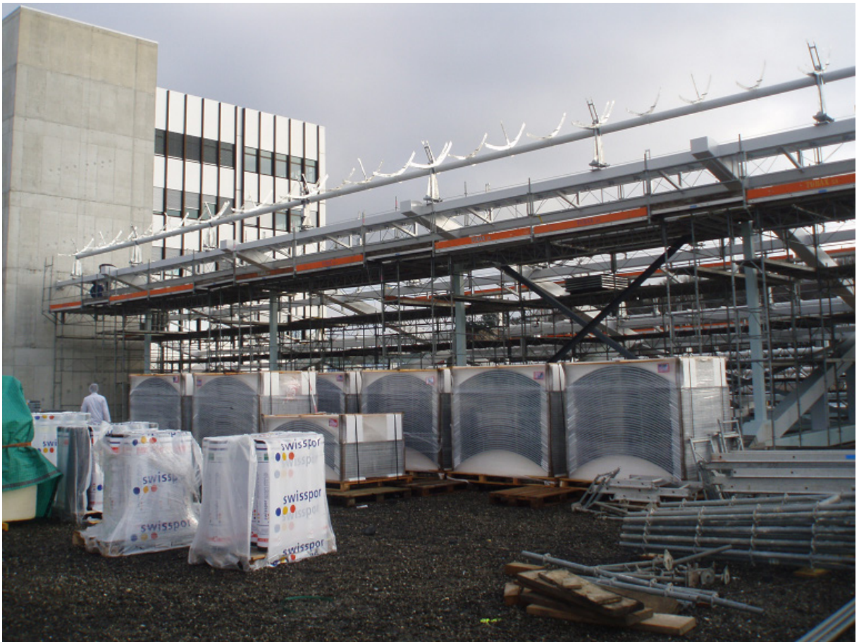
Installation prête pour la mise en place des collecteurs paraboliques
