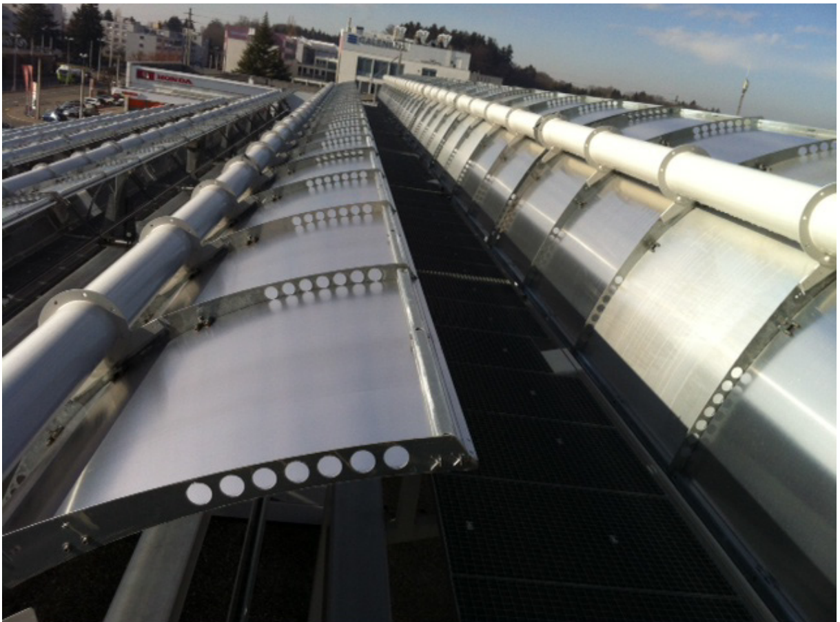
Installation prête pour la mise en place des collecteurs paraboliques
