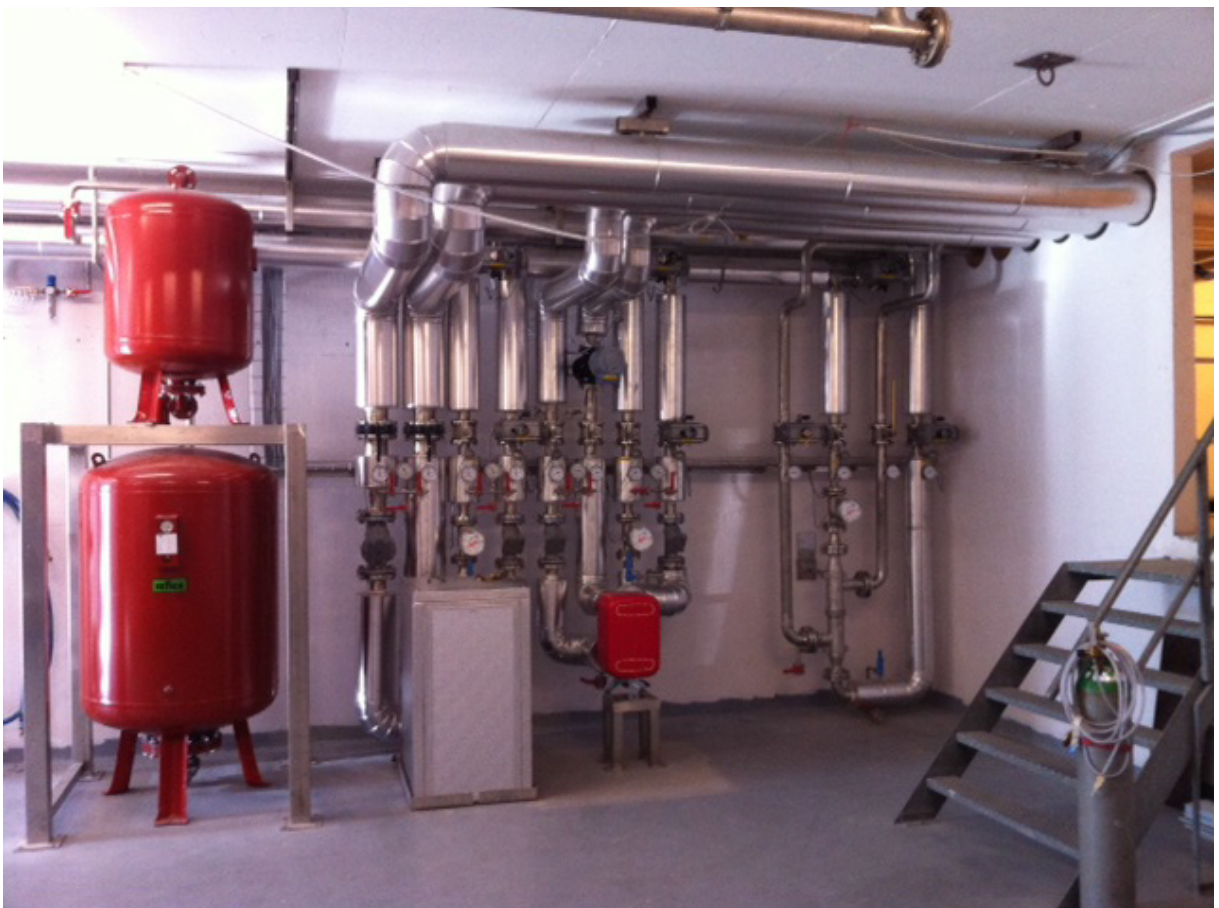
Système d'échangeurs servant à la récupération de l'énergie terminé
