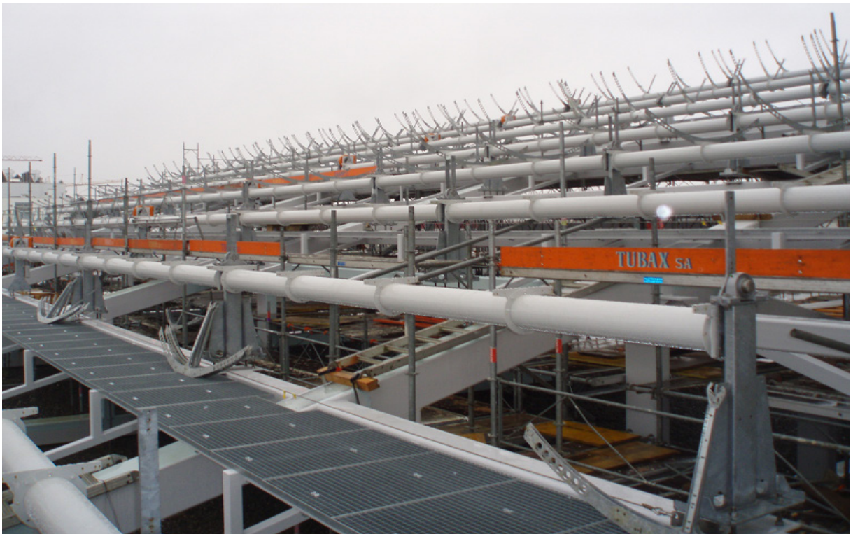
Montage des supports des collecteurs paraboliques
