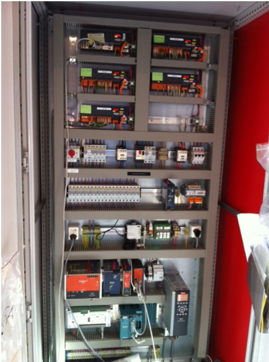
Armoire de commande de l'installation
