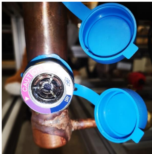
Figure 14 : Interface liquide/ vapeur dans le voyant inférieur du réservoir de liquide.
