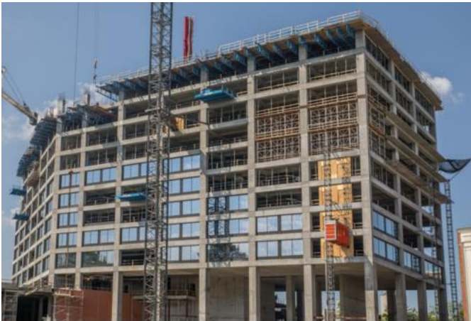
Abb. 93: Betonskelettbau in Atlanta, USA. © CarbonCure™
