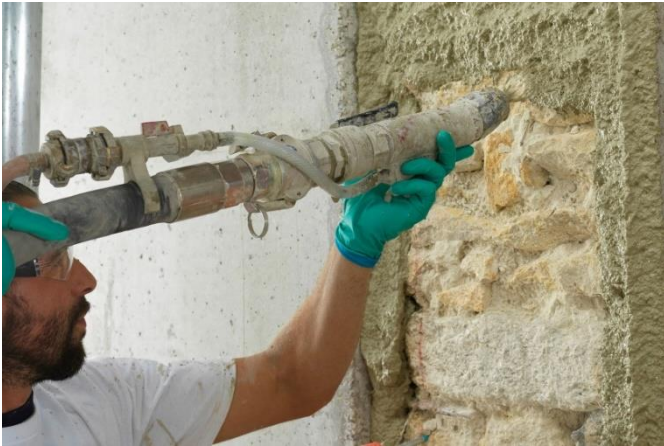
Abb. 92: Aufbringen von PARNATUR-Dämmputz. © Sika AG
