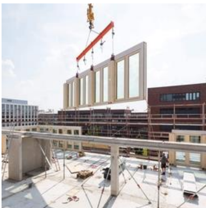
Abb. 65: Vorfertigung von Systembauteilen führt zu Zeit- und Effizienzgewinnen. © CREE GmbH
