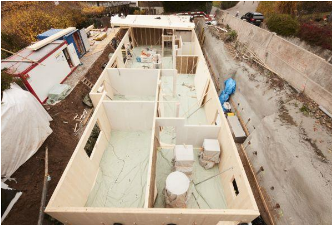
Abb. 71: Kellergeschoss in Bau in Thun. © Foto: timbatec.com
