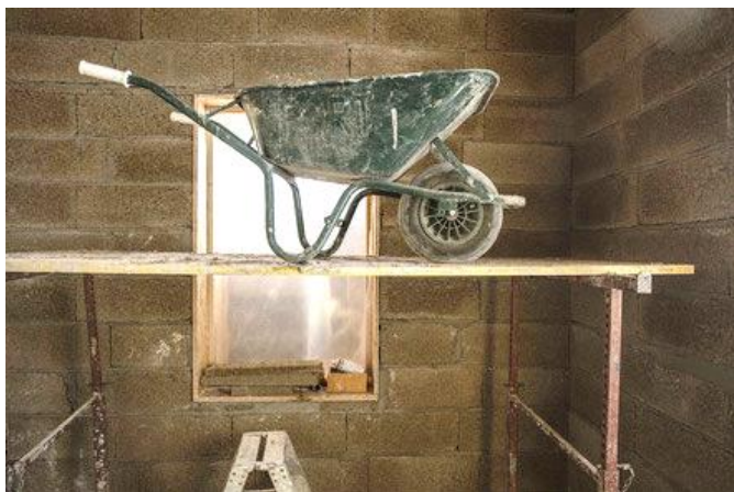
Abb. 79: Aussenwand aus Hanfsteinen. © Schönthaler OHG
