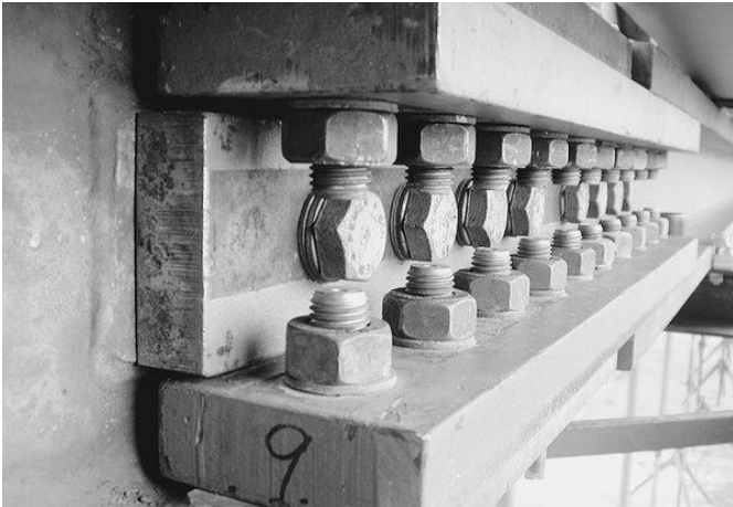
Abb. 77: Geschraubte statt geschweisste Verbindung im Stahlbau. © Foto: bauforumstahl / G. Machura
