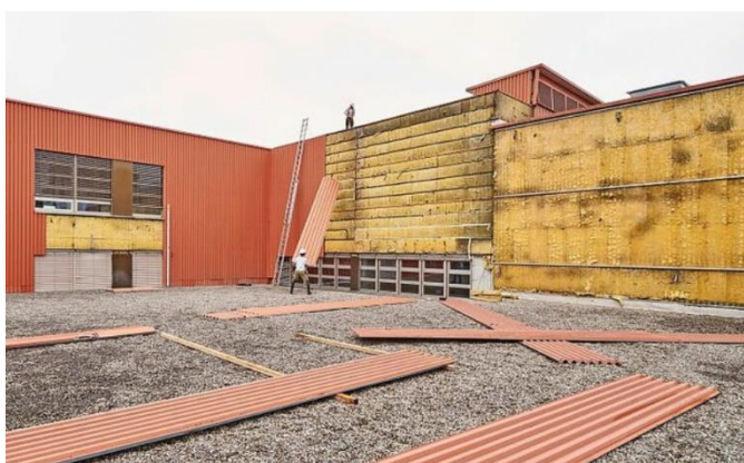
Abb. 76: Gebrauchte Fassadenteile werden für die Wiederverwendung beim Gebäude 118 am Lagerplatz Winterthur rückgebaut. © Martin Zeller
