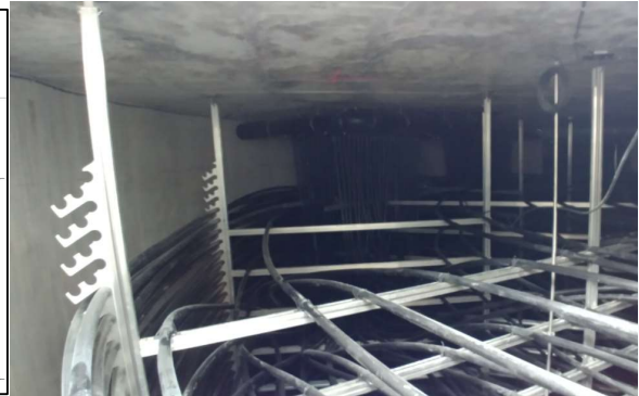
Abbildung 2: System-Schnitt und Foto Ausführung zylinderförmiger Eisspeicher Haus B
