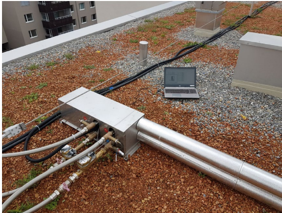
Abbildung 63: Wärmemengen –Messstellen der Solaranlage P&D Teil
