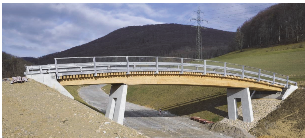
Abb. 45: Überführung in Horen mit blockverleimten BSH Trägern
