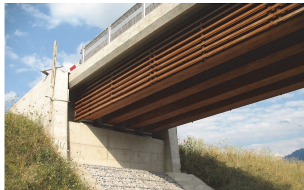
Abb. 2: Holz-Beton Verbundbrücke bei Bulle
