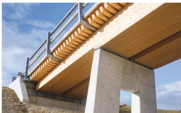
Abb. 1: Überführung in Horen mit blockverleimten Brettschichtholzträgern
