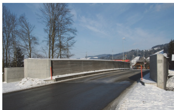
Abb. 8: Ansicht Obermattbrücke im Emmental, Balkenbrücke mit Spannweite 32 m und Nutzlast 40 Tonnen
