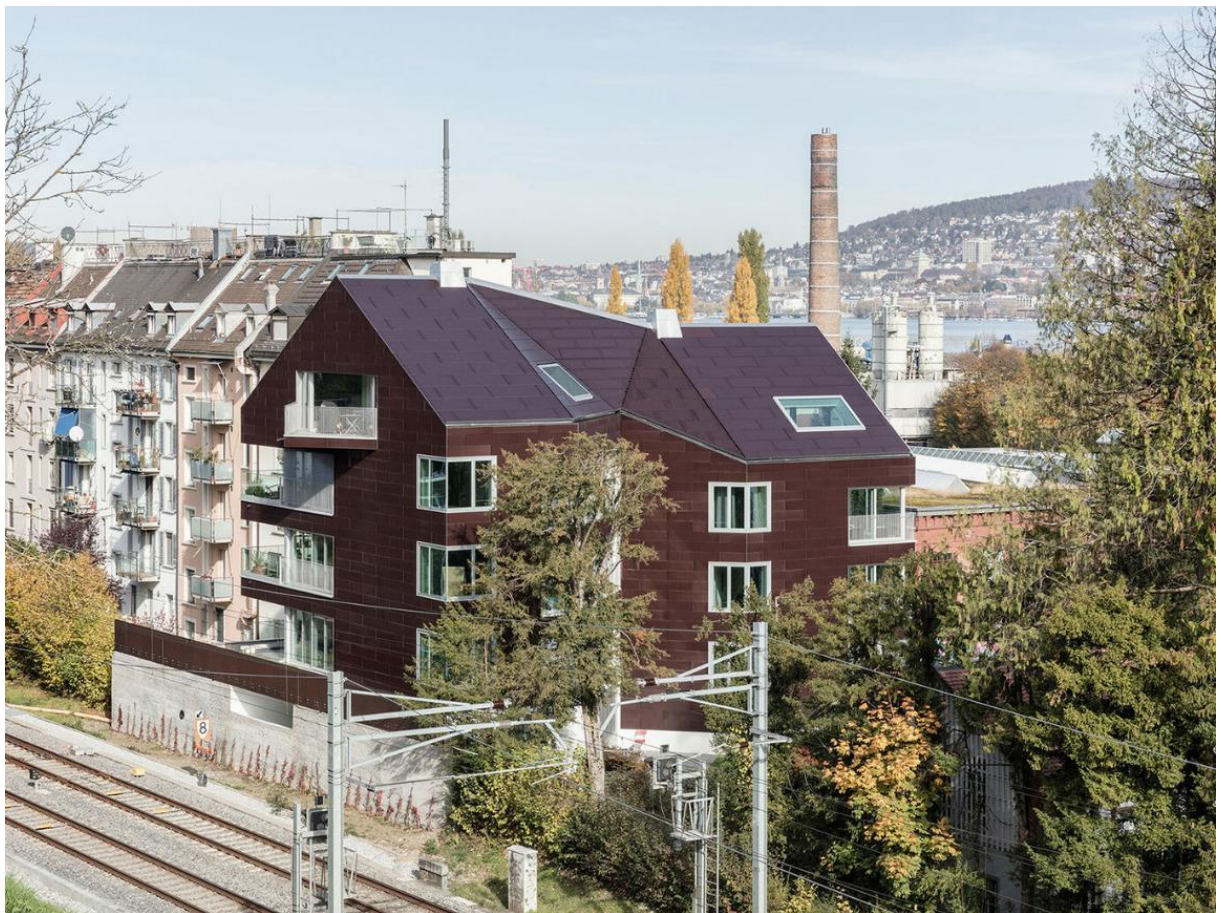
Gebäudeintegrierte Photovoltaik, Gebäude Solaris 416 © HUGGENBERGERFRIES ARCHITEKTEN 2019
