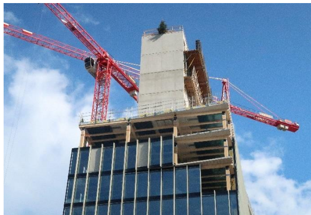
Abbildung 29: Ansicht des Gebäudes Suurstoffi BF1 bzw. Arbo während des Baus mit Betonkern und nachfolgendem Holzbau
