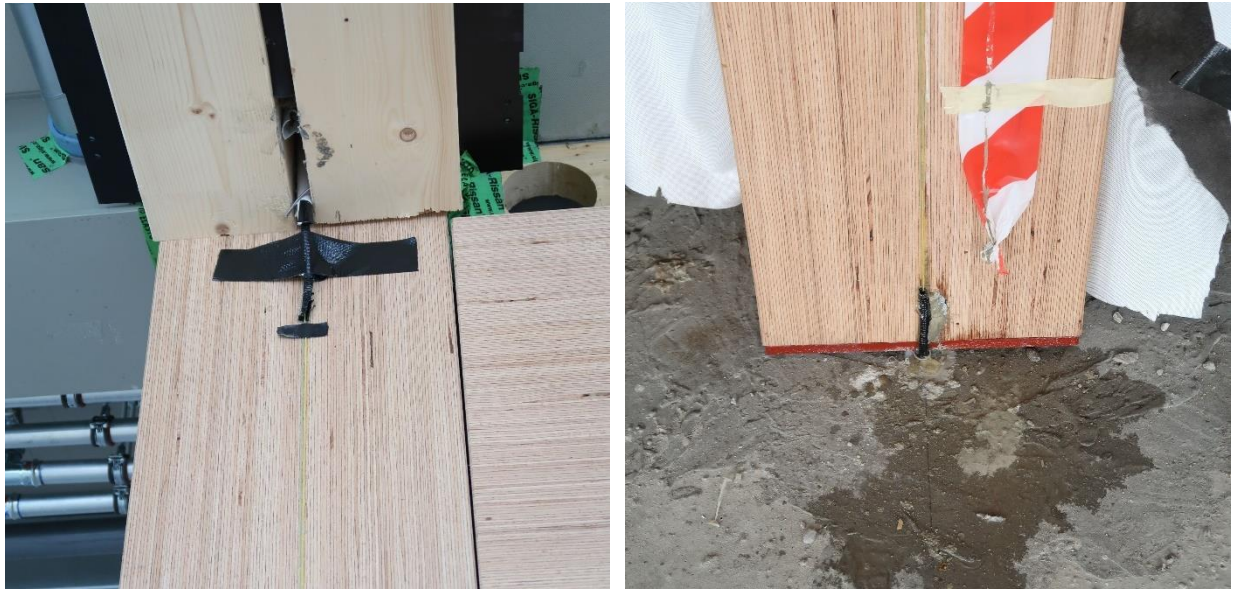
Abbildung 24: Kabelführung durch die Deckenbereiche
