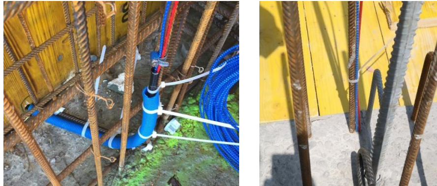
Abbildung 21: Befestigung der Sensoren am unteren Ende und Durchführung durch Schalung nach aussen (links) und Befestigung der Sensoren entlang Bewehrung (rechts)
