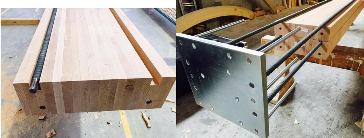
Abb. 1: Einbringen der Stahlbewahrung ins Bu-BSH
