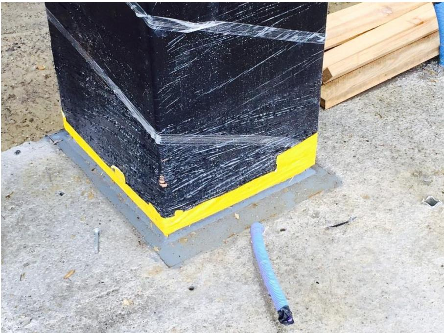
Abb. 14: Bu-Stützen auf Grundplatte im Beton aufgeschweisst
