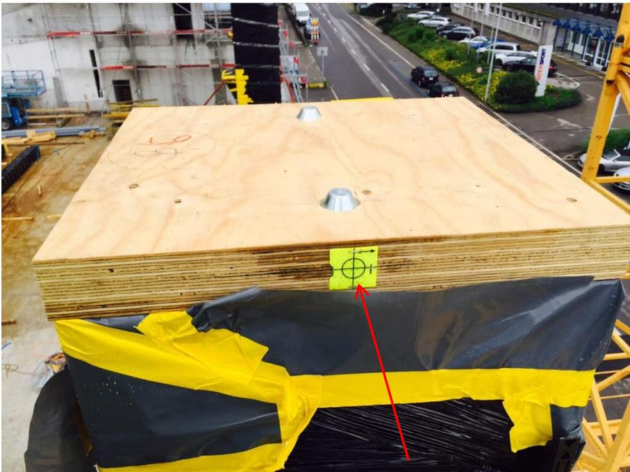
Abb. 16: Genaues positionieren der Bu-Stützen mit dem Theodolit
