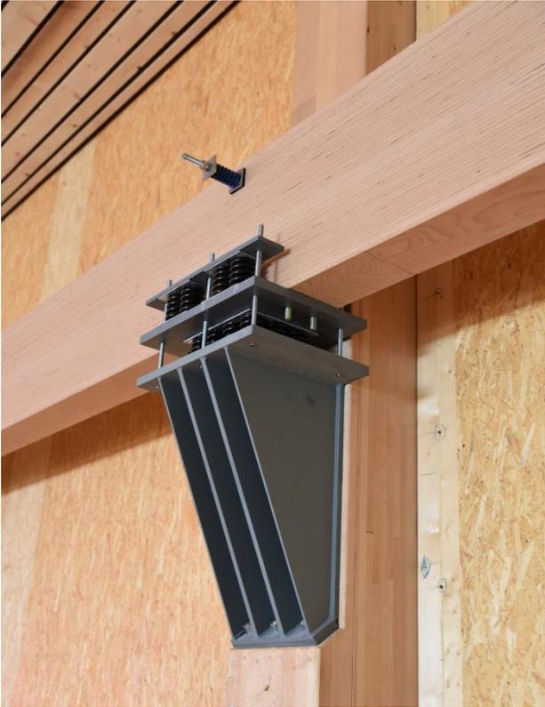
Abb.17: Auflagerdetail Kranbahn auf einem Federpaket gelagert
