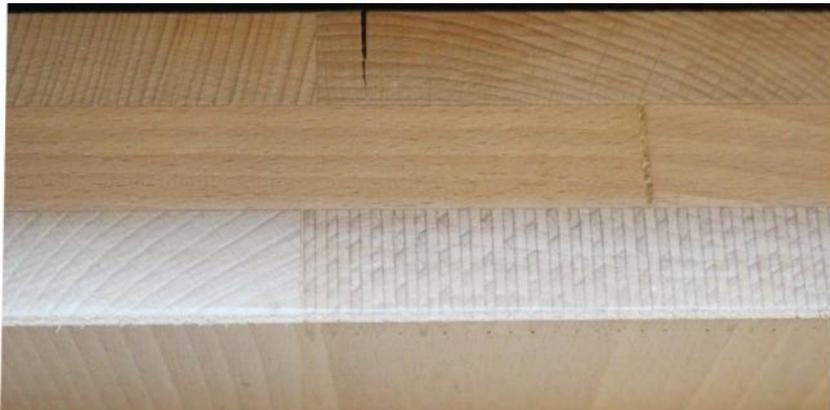
**Abbildung 47: Querschnittsfläche Brettsperrholz unter Fenster mit Riss**
